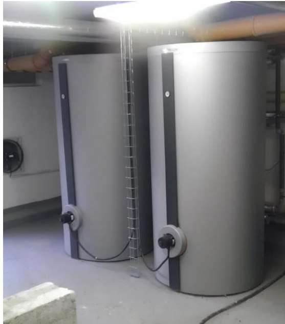
Obrázek 4: 1000l bojler na TV
