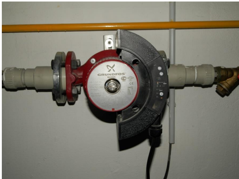
Obrázek 5: čerpadlo Grundfos Magna 40-120 F(N)
