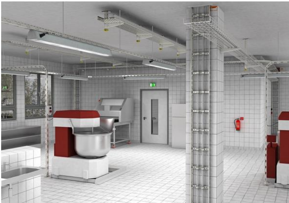
Obr. 14 - Instalace ve žlabech a na roštích
