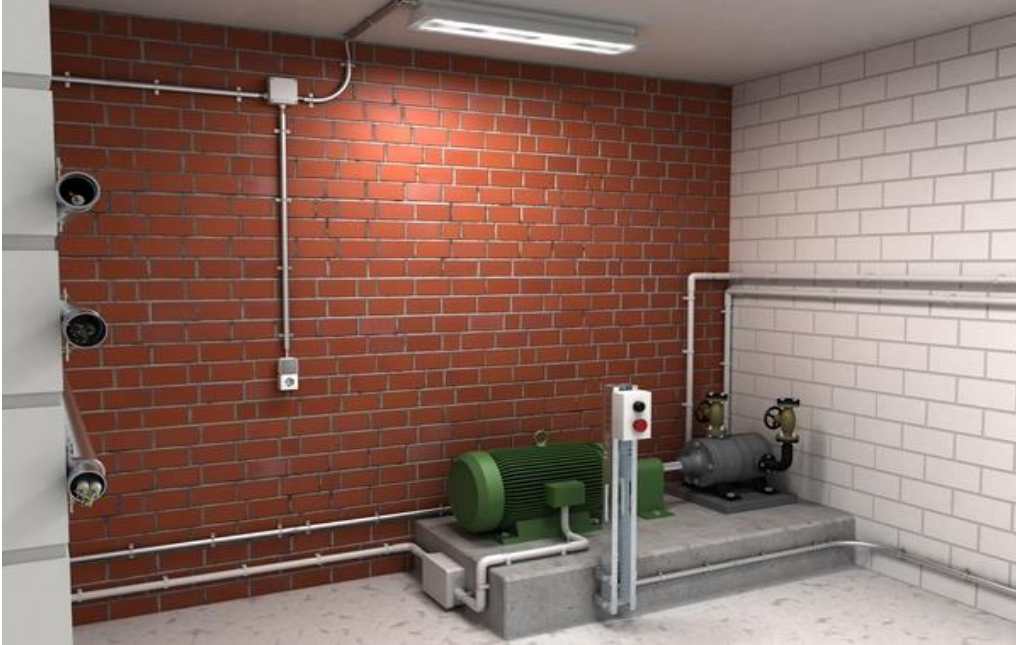
Obr. 10 - Instalace v trubkách
