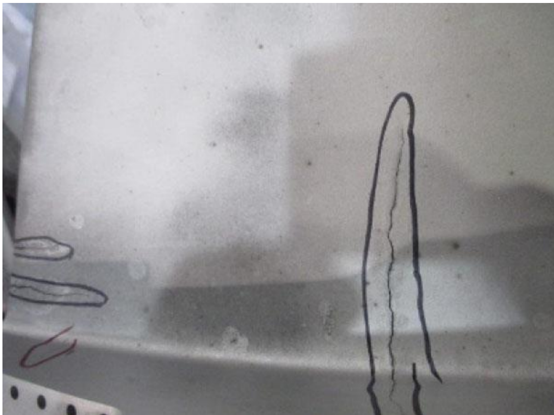
Obr. 14: Praskliny - sací část turbíny, zdroj [11]
