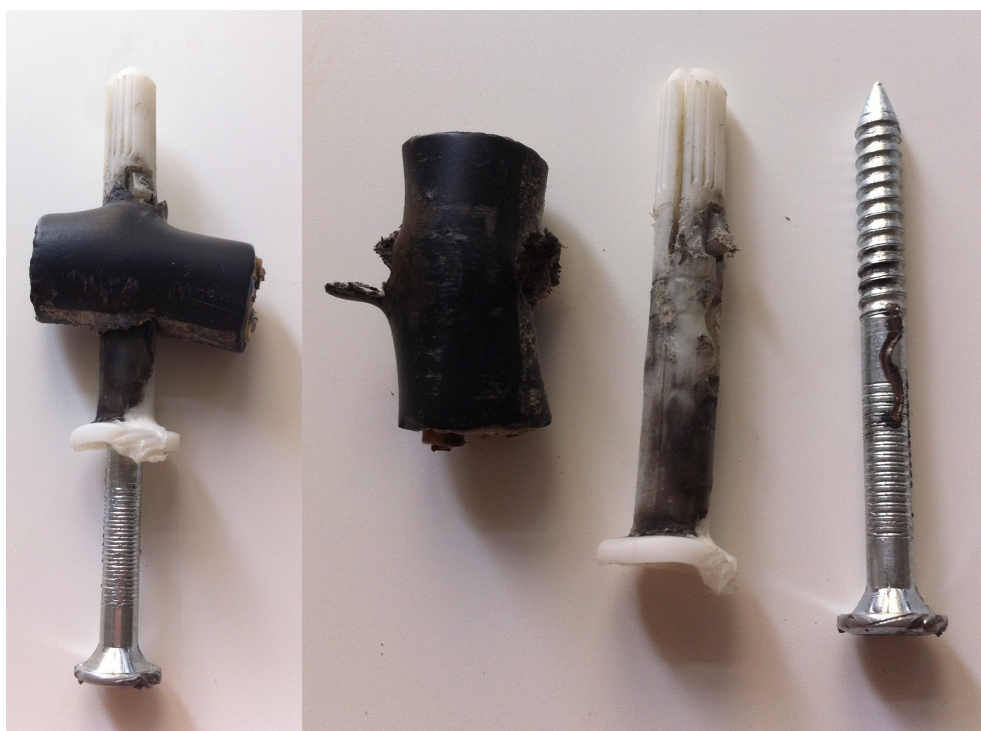
Obrázek 1.2: Provrtaný kabel - ukázka jedné z možných příčin vzniku poruchového elektrického oblouku z praxe
