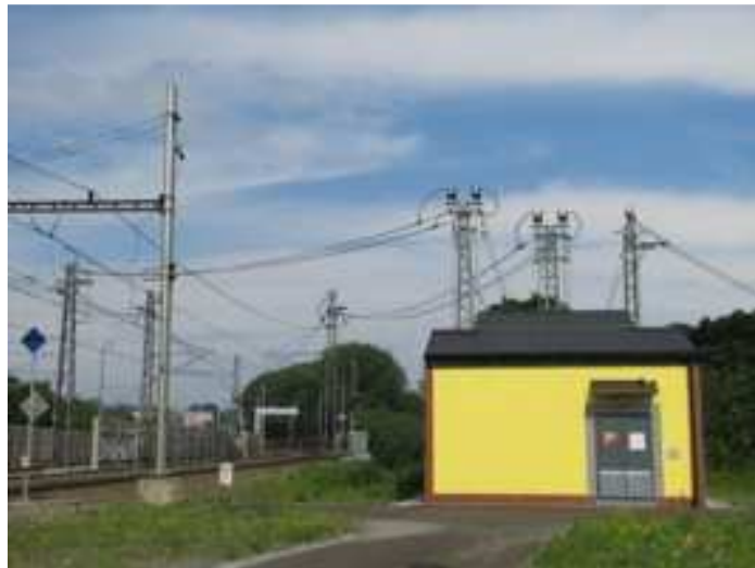
Obr. 5 Spínací stanice Zábřeh na Moravě 3 kV DC
