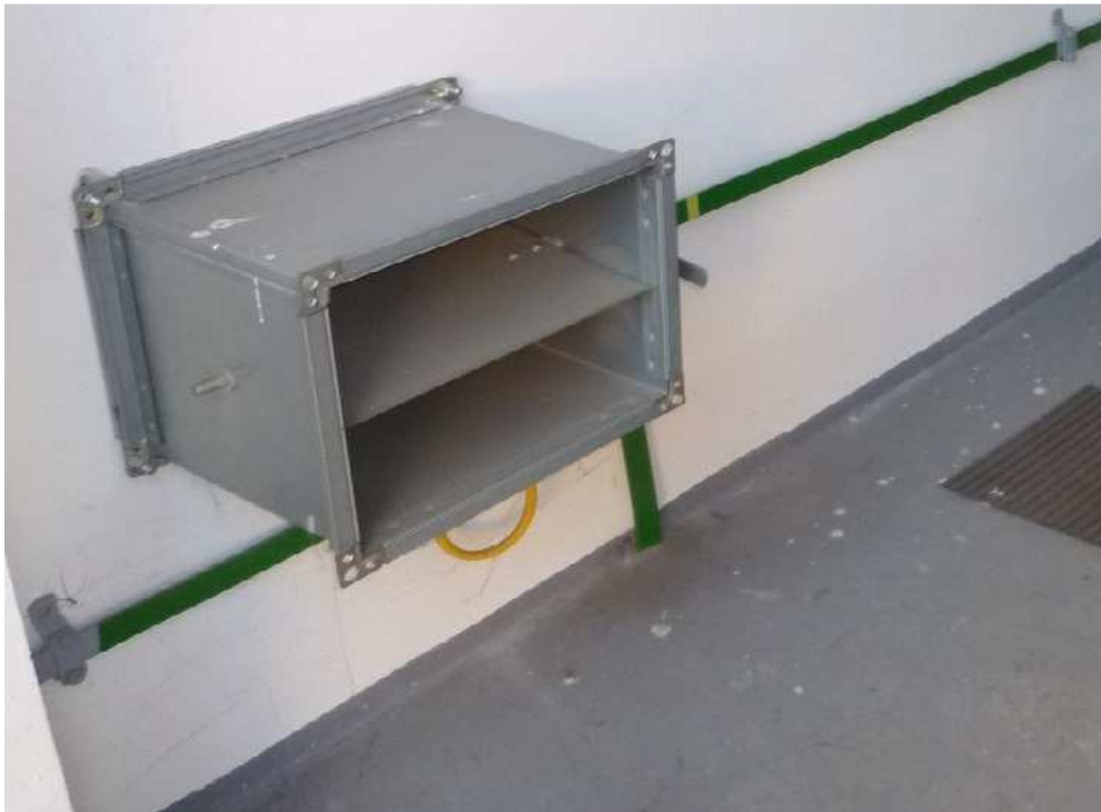
Obr. 28 Příklad vnitřní uzemnění – pásek FeZn 30x4
