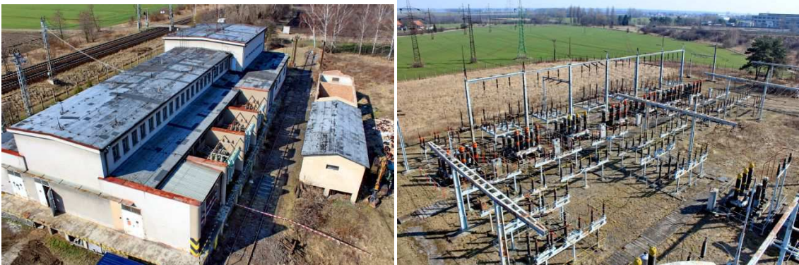
Obr. 2 a 3 TNS Pečky - budova a rozvodna 110 kV (před rekonstrukcí)
