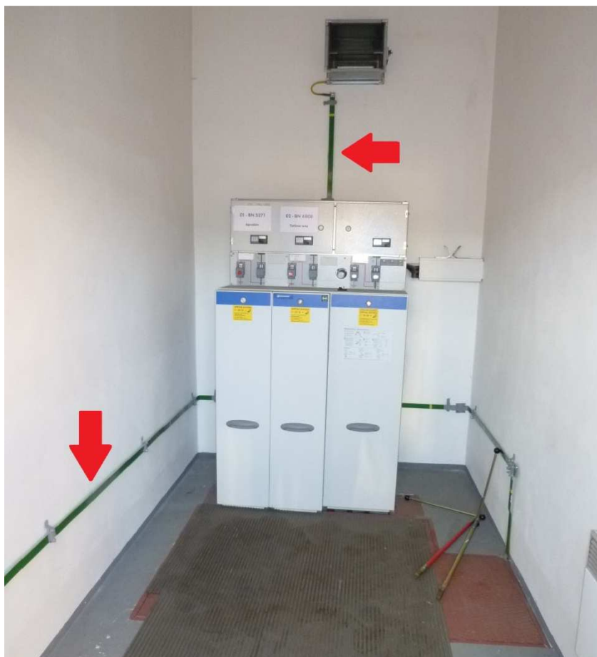
Obr. 29 Příklad vnitřní uzemnění v rozvodně vn
