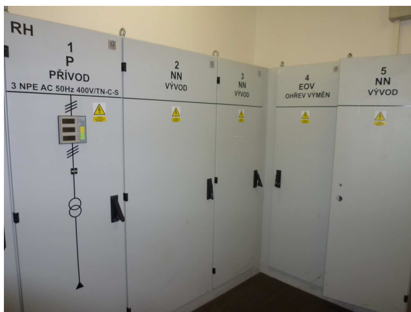
Obr. 21 Příklad provedení rozvodny nn - rozvaděč RH
