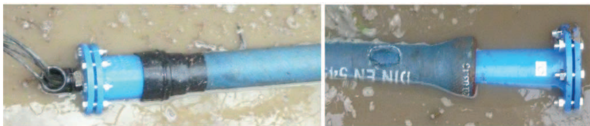
Obrázek 4.15: Ukončení pokusného potrubí s vyvedením vodičů pro připojení DC proudu
