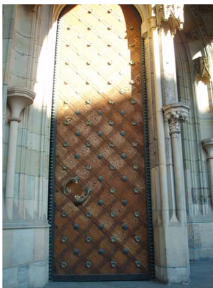
Obr.č. 47 -Zlatá brána, 1950 -1959, pohled na dveře. Jan Sokol navrhl dřevěné dveře s kovovými aplikovanými plastikami.Váha dveří nakonec způsobila, že problém konstrukce hrál při výtvarném řešení velmi podstatnou úlohu. Dřevěná konstrukce tak velikého dřevěného křídla je sama o sobě složitým úkolem, také díky požadavku, aby obě čelní strany byly hladké., foto: K. U. Kasanová
