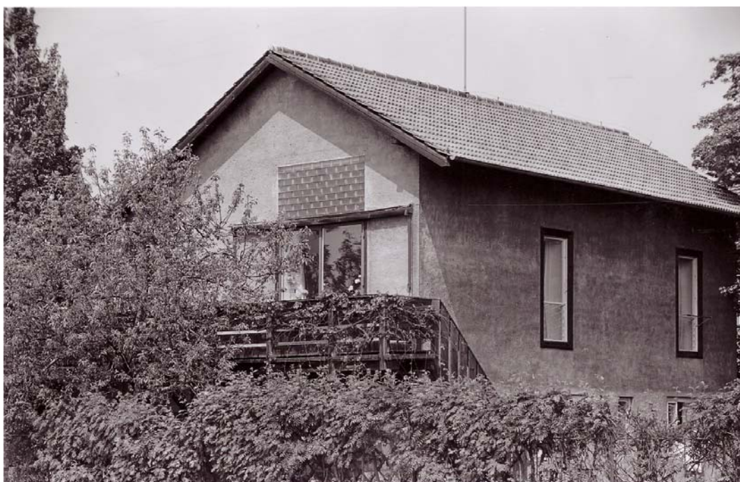
Obr.č..74 Jan Sokol, vlastní rodinný dům, pohled,1937, velkorysý koncept interiéru se nepromítl uspokojivě ve všech pohledech na dům. Některé fasády působí nevyváženým dojmem. fotografie, Jan Svoboda, 1978,zdroj:soukromý archiv rodiny Václava Sokola
