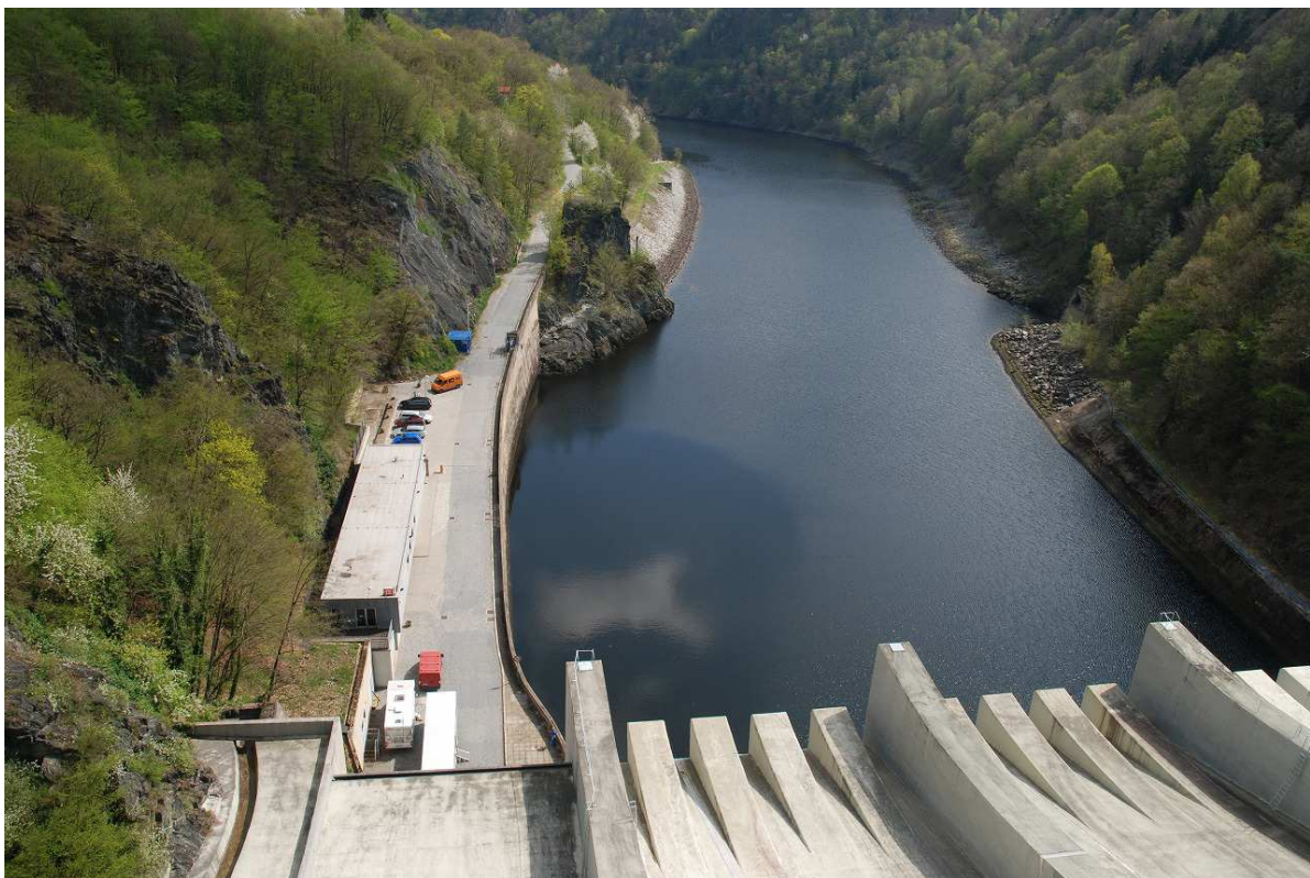
Obrázek 13: Umístění regenerační stanice v blízkosti vodního toku - VE Slapy
