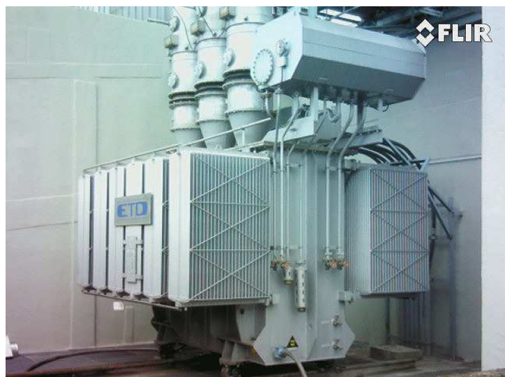
Obrázek 26: Generátorový transformátor TE Mělník
