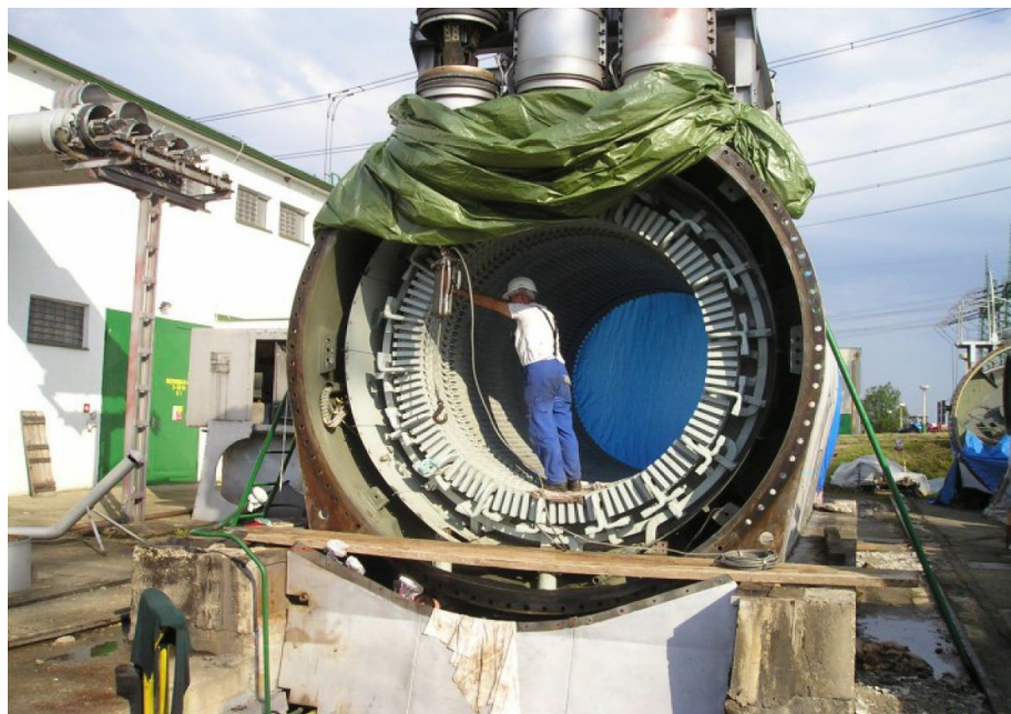
Obr. 9: Rotační kompenzátor v R Krasíkov při generální opravě [42]
