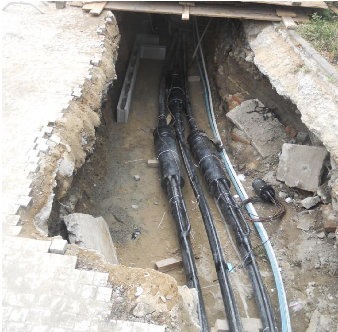
Obr. 20: Optický kabel jako snímač teploty fáze silového kabelu
