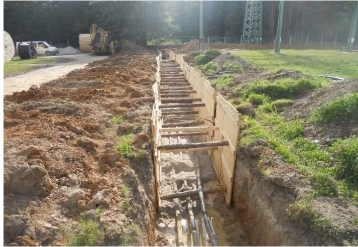
Obr. 1: Kably uložené přímo v zemi
