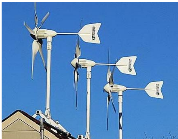
Obr. 15 – Větrná elektrárna ANERN 3000 W 5BLADE (Zdroj [22])
