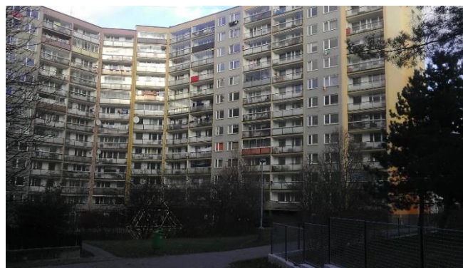
Obrázek 1: Pohled na bytový dům z vnitrobloku.
