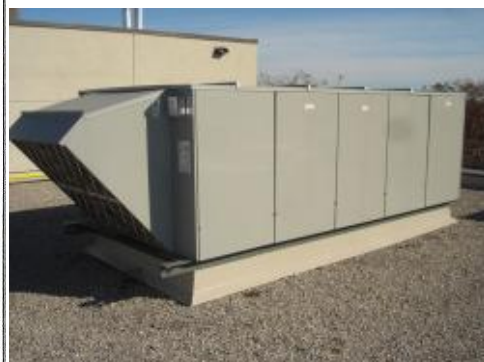
Obr. 18: Ukázka jednotky centrální rekuperace. Zdroj [14]
