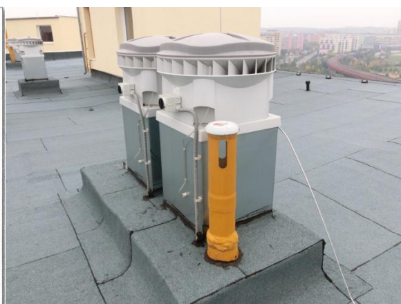
Obr. 12: Ventilátor současnýho systému centrálního podtlakového odvětrávání.
