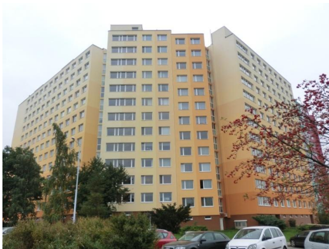
Obr. 10: Současný stav sledovaného objektu. Zdroj [foto autor]
