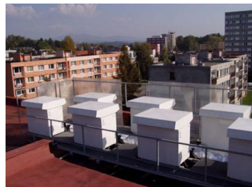
Obr. 22: Kaskáda čerpadel vzduch-voda umístěných na střeše. Zdroj [14]
