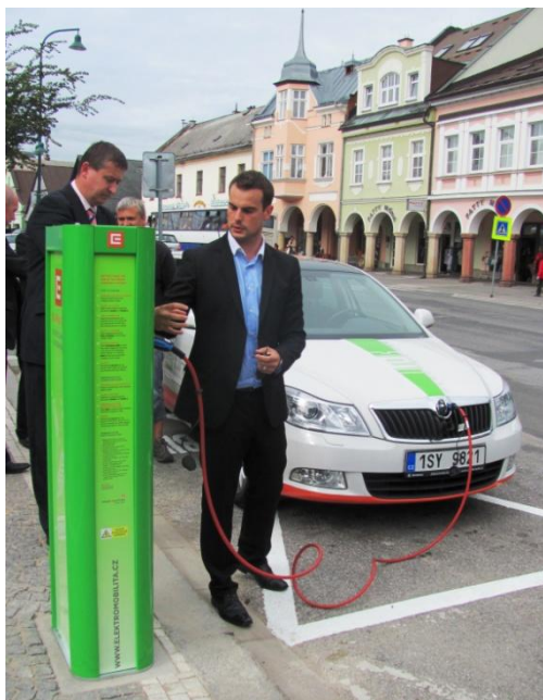
Obrázek 7 - Dobíjecí stanice elektromobilů na náměstí T. G. Masaryka [41]
