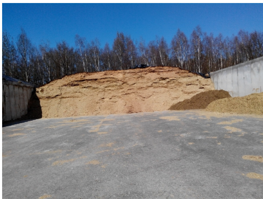
Obr. 10 Silážní žlab bioplynové stanice Těbo
