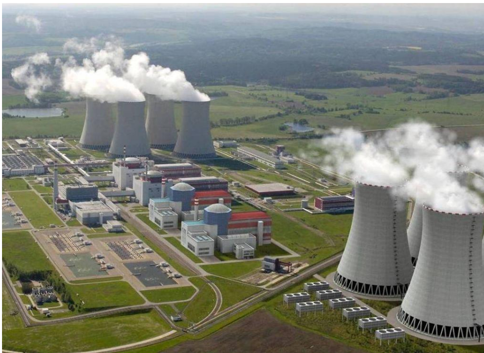
Obrázek 10. Dostavba jaderné elektrárny Temelín
