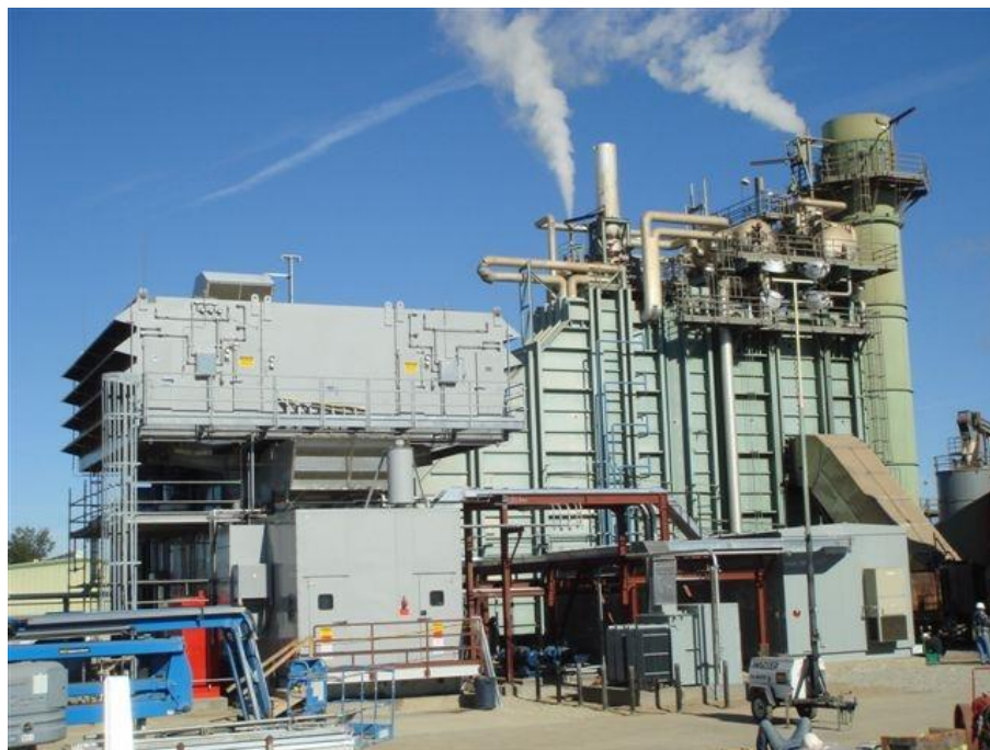
Obrázek 11 - Elektrárna s turbínou LM6000 - PC SPRINT, společnost Algonquin Power Sanger LLC 18
