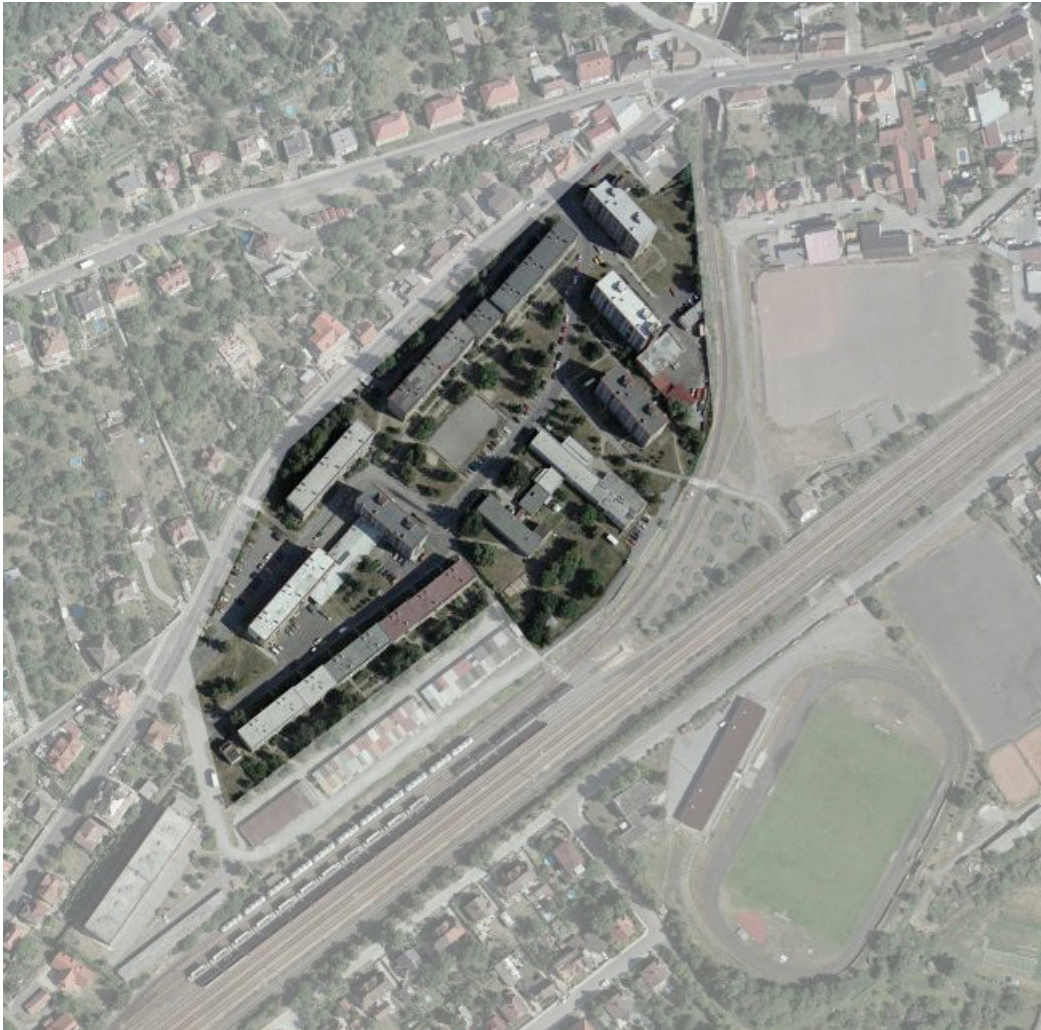
Obr. 10. Sousedství Staré sídliště - ortofoto snímek
