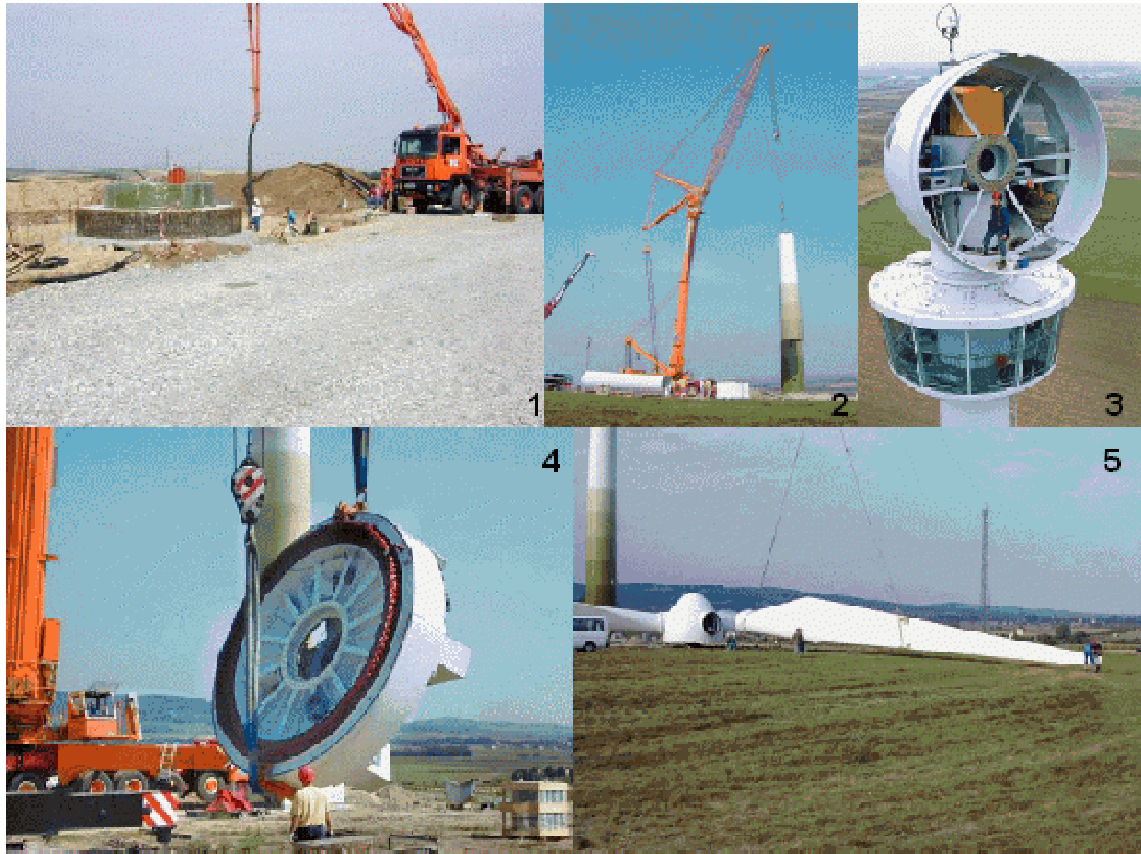
Obr. 21 Průběh stavby elektrárny[6]
