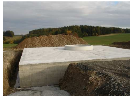
Obr. 12 Hotový betonový základ [2]
