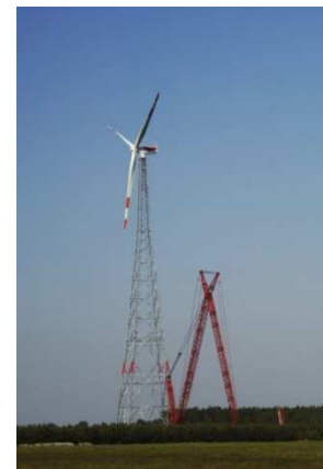
Obr. 15 Příhradový stožár [2]
