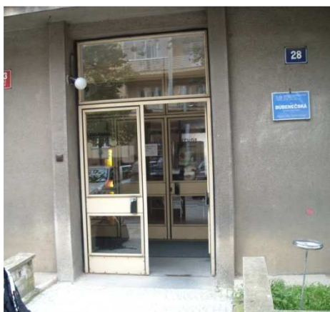
OBR. 38: BUBENEČSKÁ KOLEJ - vstup do objektu
