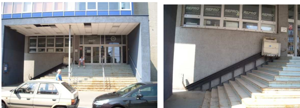
OBR. 32: TECHNICKÁ MENZA - hlavní vstup z ulice Jugoslávských partyzánů
