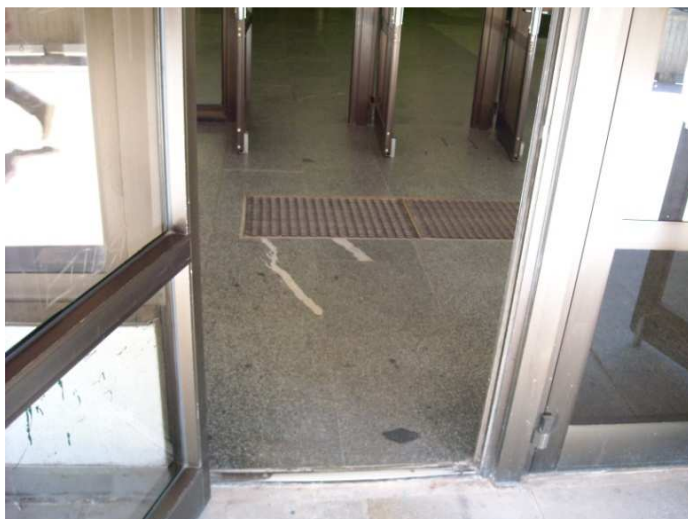
OBR. 29: STUDENTSKÝ DŮM - vstup do objektu v 2.np
