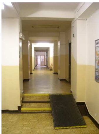
OBR. 40: BUBENEČSKÁ KOLEJ - mobilní dřevěná rampa v 1.np
