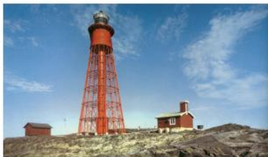
Obr. 12: Jedna z prvních švédských konstrukcí s duplexním povlakem – Maják Pater Noster (v roce 1868 byl žárově pozinkován a následně byl aplikován nátěrový systém) [8]
