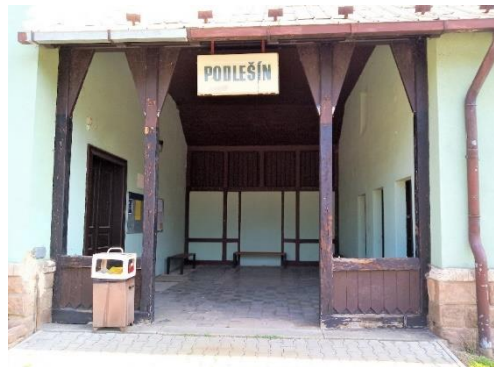
Obr. 50 Přístřešek pro cestující v rámci staniční budovy.
