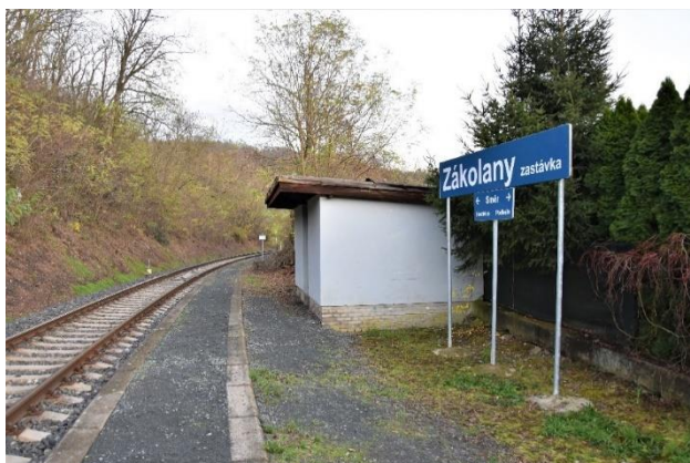
Obr. 44 Železniční zastávka Zákolany zastávka s betonovým přístřeškem pro cestující.
