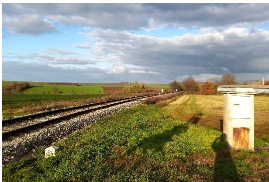
Obr. 78 Úsek tratě u železničního přejezdu číslo P2253, v místě, kde by bylo možné vybudovat zastávku u Noutonic.
