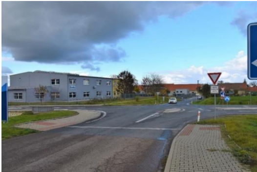
Obr. 25 Chodník od zastávky Dobrovíz do obce Dobrovíz a logistického areálu s vyznačeným místem pro přecházení, bez veřejného osvětlení.
