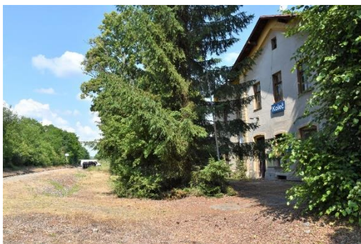
Obr. 46 Železniční zastávka Koleč se sypanou nástupní hranou (na fotografii vlevo) a s bývalou, nyní nevyužívanou, nádražní budovou.
