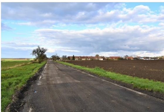
Obr. 37 Komunikace vedoucí od stanice Noutonice do obce Noutonice. V době pořízení fotografií byla komunikace v rekonstrukci.
