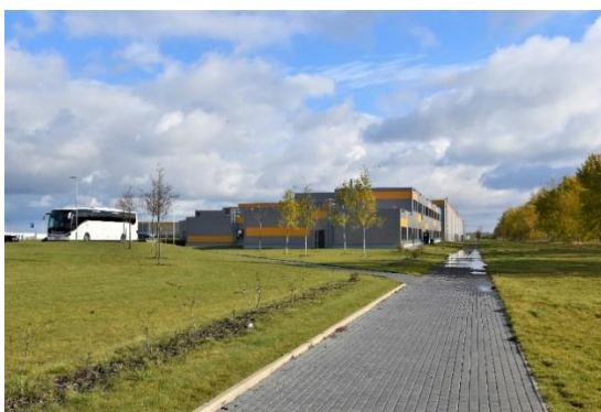
Obr. 17 Chodník pro pěší vedoucí od zastávky Jeneč zastávka k logistickému parku VGP.
