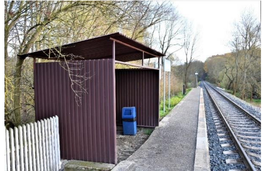
Obr. 40 Železniční zastávka Kováry s plechovým přístřeškem pro cestující.
