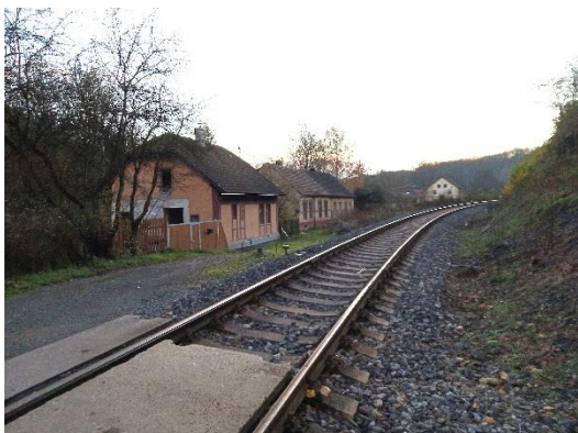
Obr. 76 Úsek tratě u železničního přejezdu číslo P2256, v místě, kam by bylo možno vybudovat novou zastávku Kováry.
