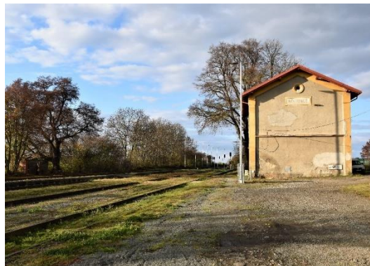
Obr. 36 Staniční budova v Noutonicích. V popředí vyštěrkovaná plocha, využitelná jako parkoviště P+R.
