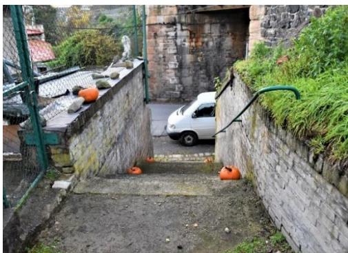
Obr. 42 Betonové schodiště na konci pěší cesty z železniční zastávky.
