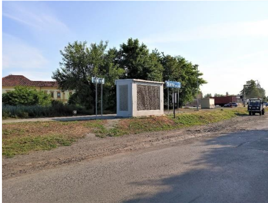
Obr. 53 Železniční zastávka Slaný předměstí s betonovým přístřeškem pro cestující.
