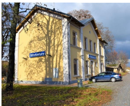
Obr. 30 Zrekonstruovaná nádražní budova stanice Středokluky.
