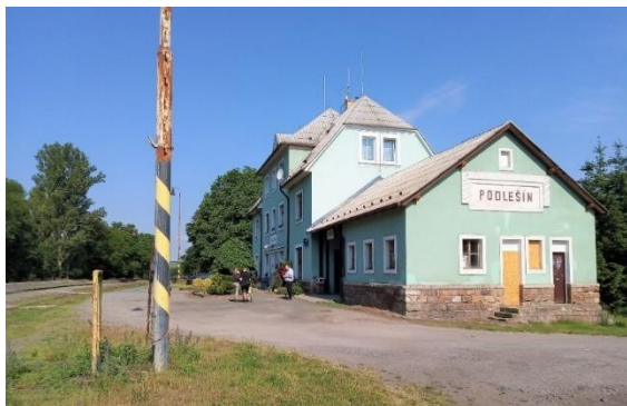
Obr. 49 Nádražní budova stanice Podlešín.
