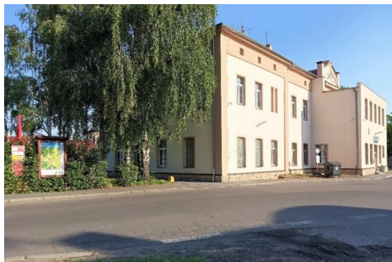
Obr. 57 Nádražní budova stanice Slaný s autobusovým stanovištěm.
