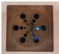
Obr. 4-4 Větrací mřížka ve světnici (foto: autor)
