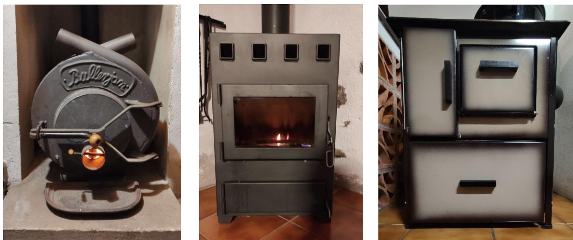
Obr. 4-6 Současné zdroje tepla na pevná paliva, zleva: teplovzdušná kamna Bullerjan typ 01, krbová kamna Bodart & Gonay Beskydy 4, sporák Kovoplast REKREANT 2-91 (foto: autor)
