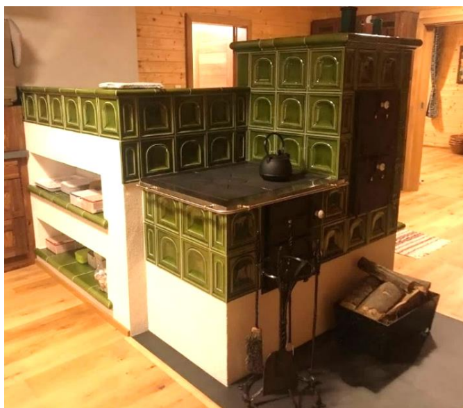
Obr. 2-14 Sporák se stavěným topeništěm a kachlovým obkladem, Petrova bouda [28]
