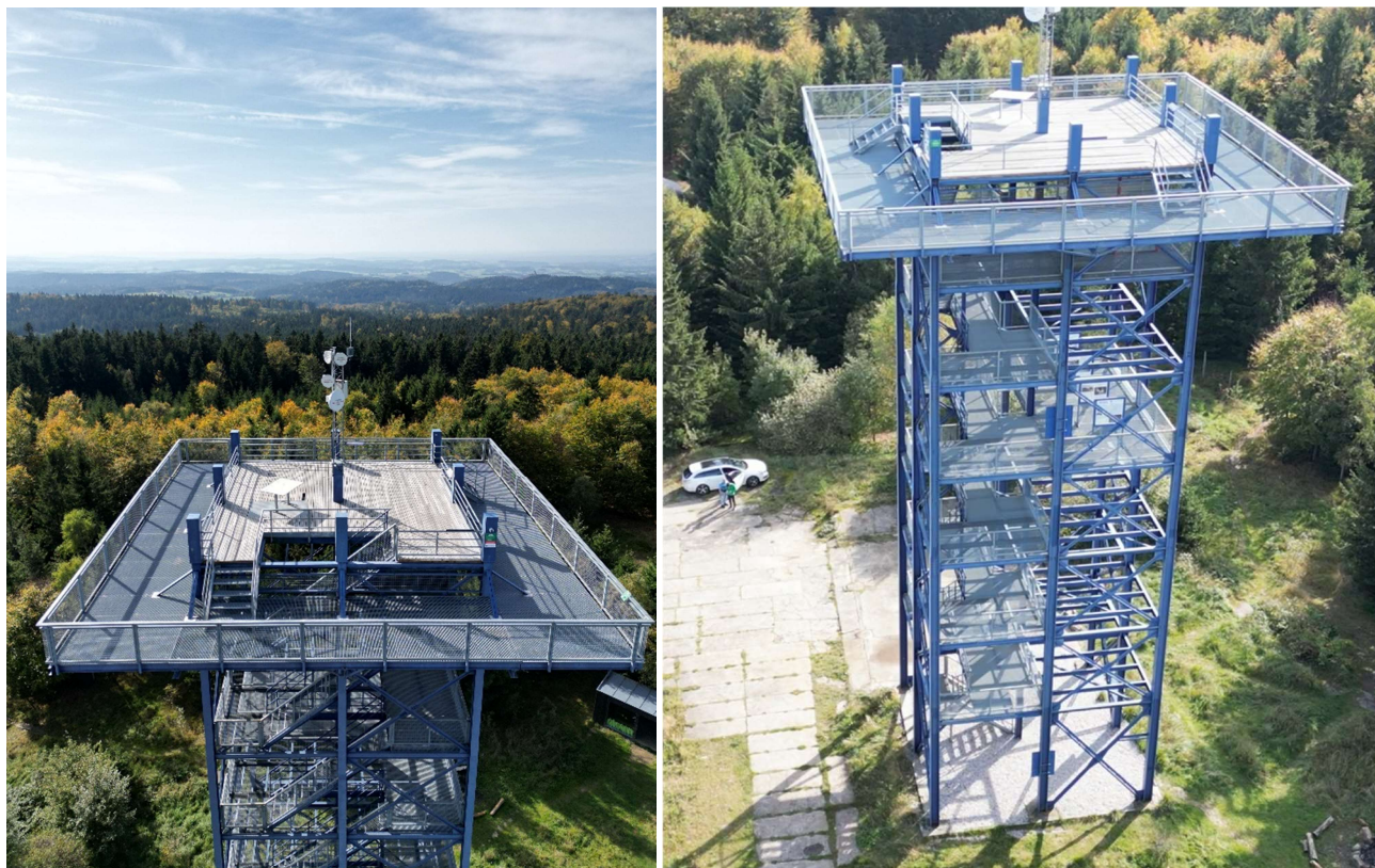
Obr. 1.3, 1.4 Skutečná stavba – Rozhledna Havran – fotografie pořízeny dronem DJI
