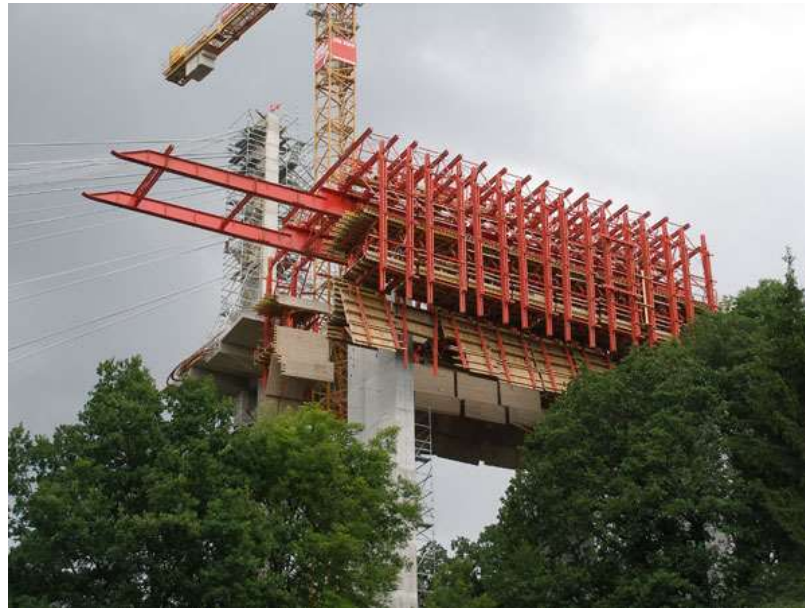
Obrázek 4.5 Pohled na posuvnou skruž
