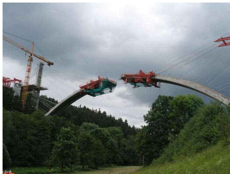
Obrázek 4.4 Letmá betonáž oblouku mostu přes Opárenské údolí
