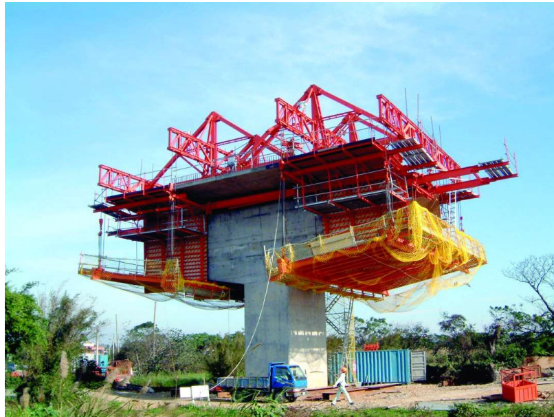
Obrázek 3.2 Zárodek s betonážním vozíkem
