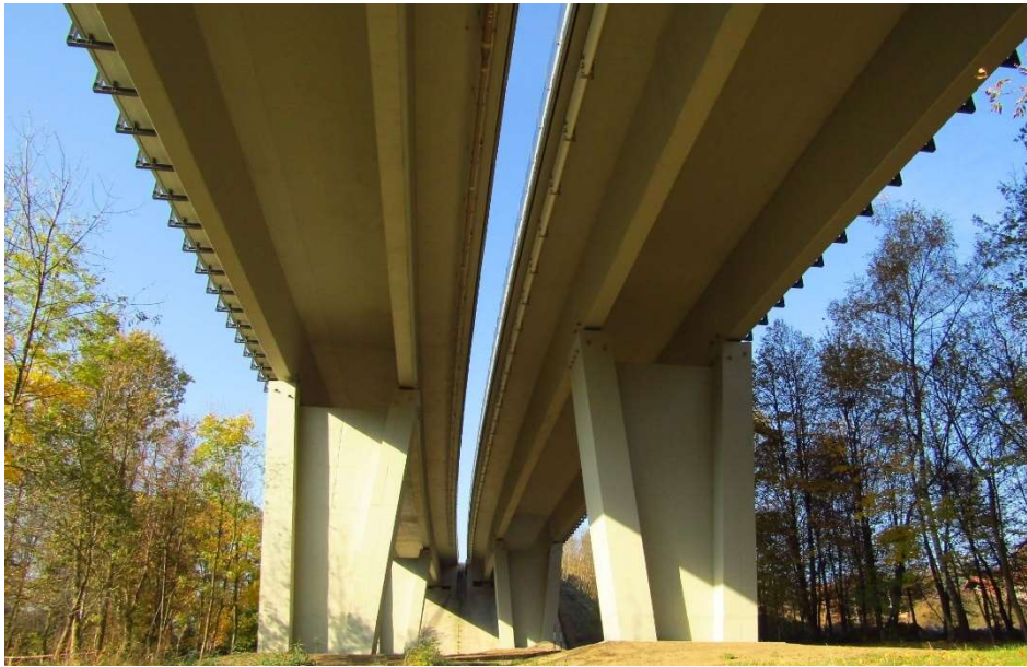
Obrázek 5.2 Most přes Sázavu ve Hvězdonicích
