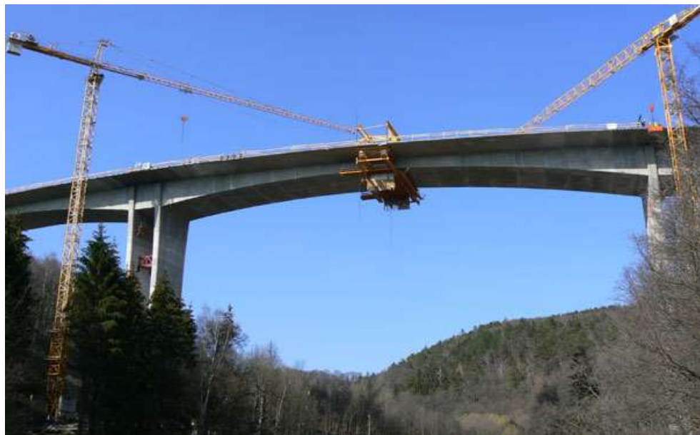
Obrázek 3.4 Dobetonování mezilehlé spáry
