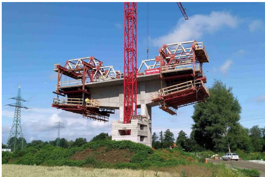
Obrázek 3.7 Zárodek s betonážním vozíkem
