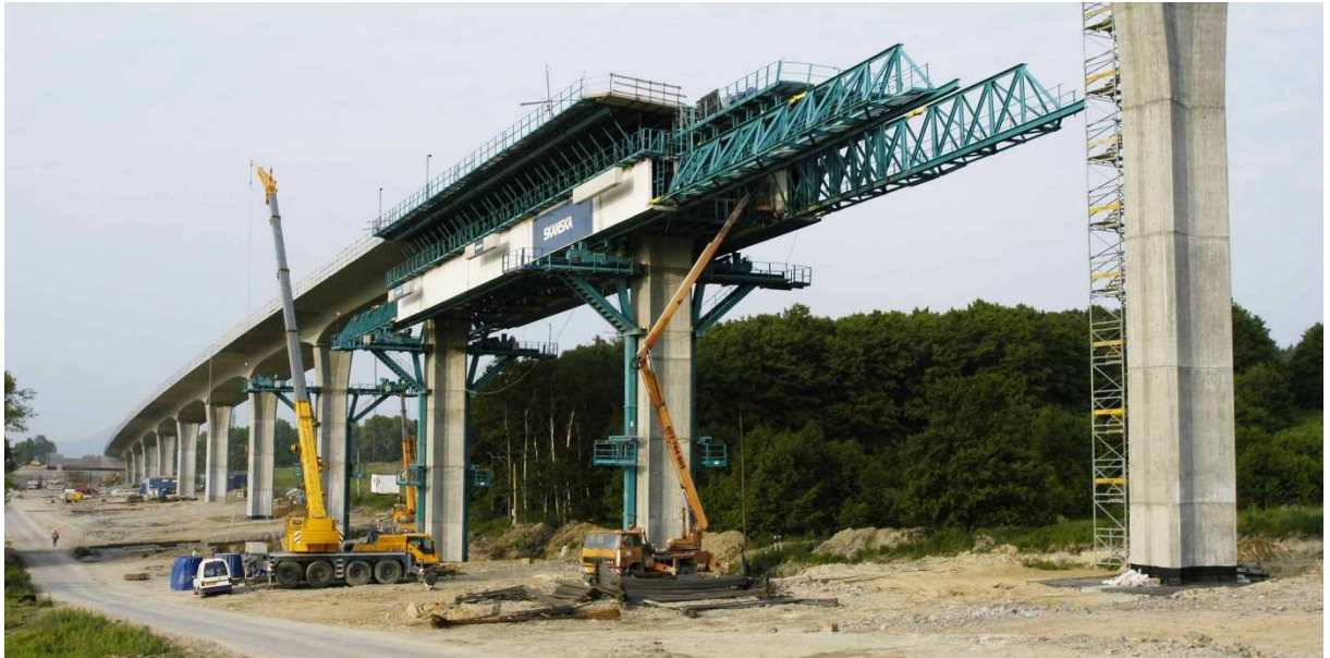
Obrázek 5.3 Posuvná spodní skruž Knínice
