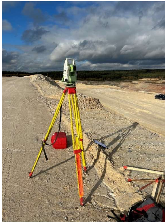
Obr. 20 Měření z volného stanoviště č. 4001
