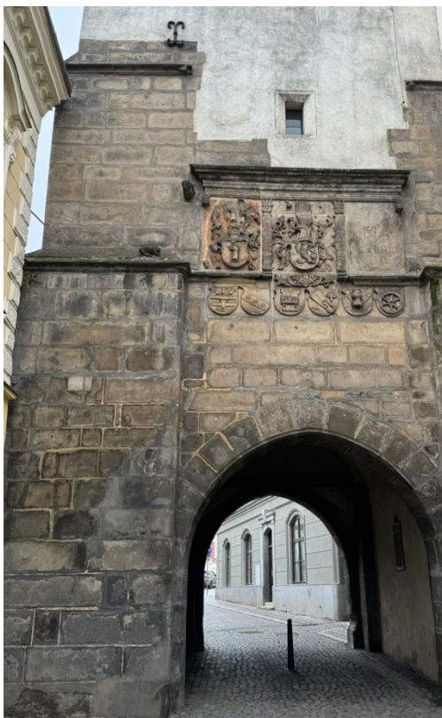
Obrázek 6 - Bližší pohled na severní průčelí
