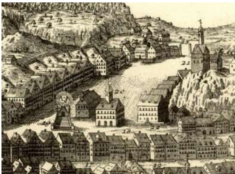
Obrázek 3 - Stará renesanční radnice na Tržišti na výřezu veduty Karlových Varů od Matthaeuse Meriana z první poloviny 17. století [10]
