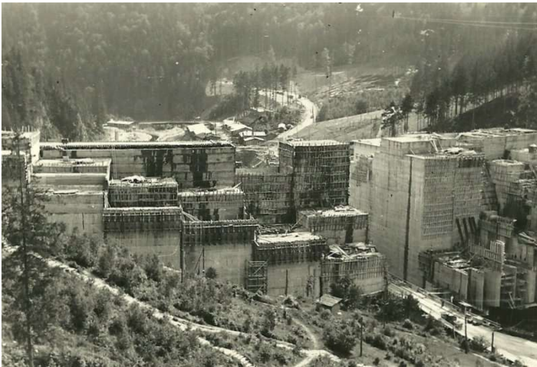
Obr. 4 - Výstavba přehrady Vír I [20]
