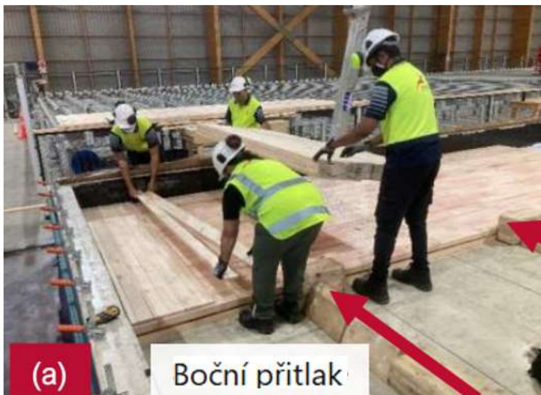
Obrázek 32 : Uspořádání vrstev s bočním přitlakem
