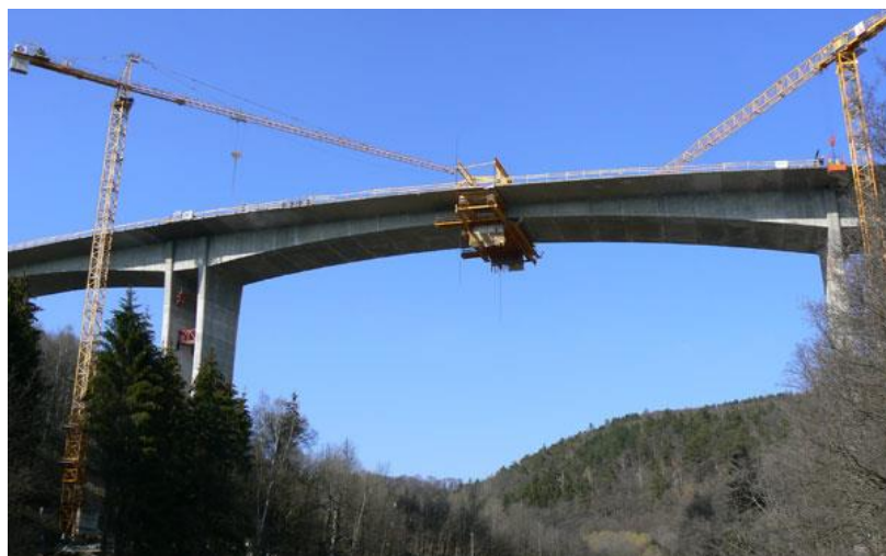
Obrázek 14 - Zmonolitnění vahadel nosné konstrukce. [15]
