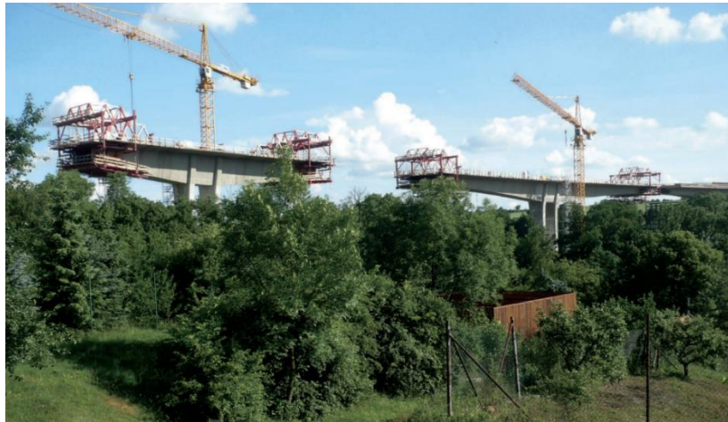
Obrázek 13 - Pohled na letmou betonáž Velemyšleves [13]
