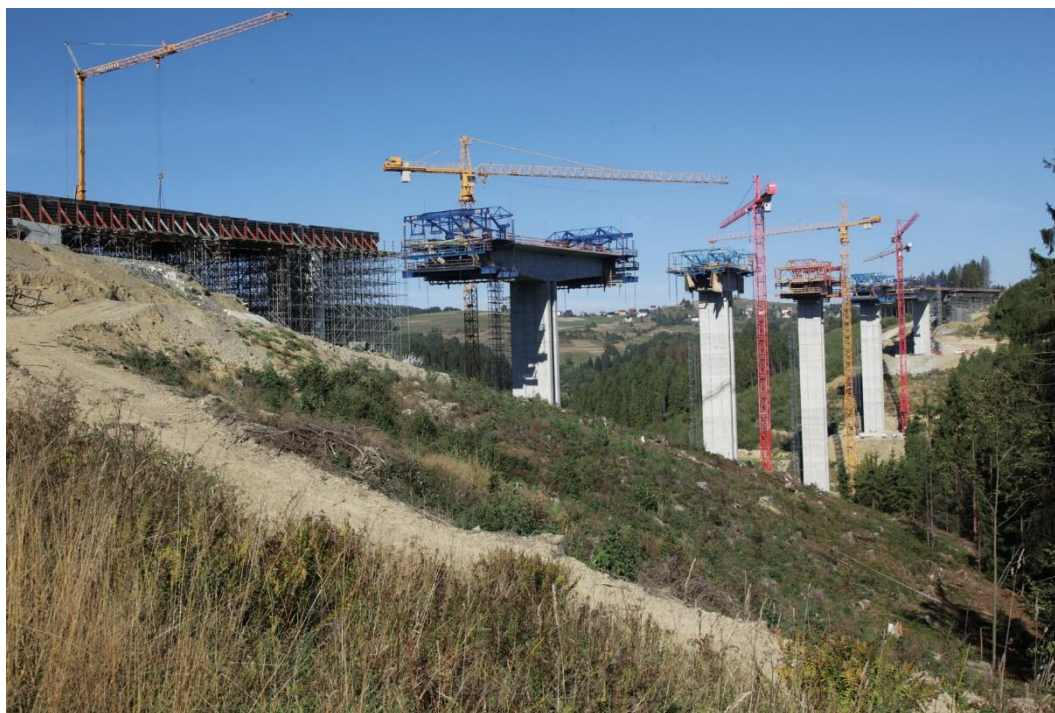
Obrázek 15 - Pohled na výstavbu mostu Valy a Reika
