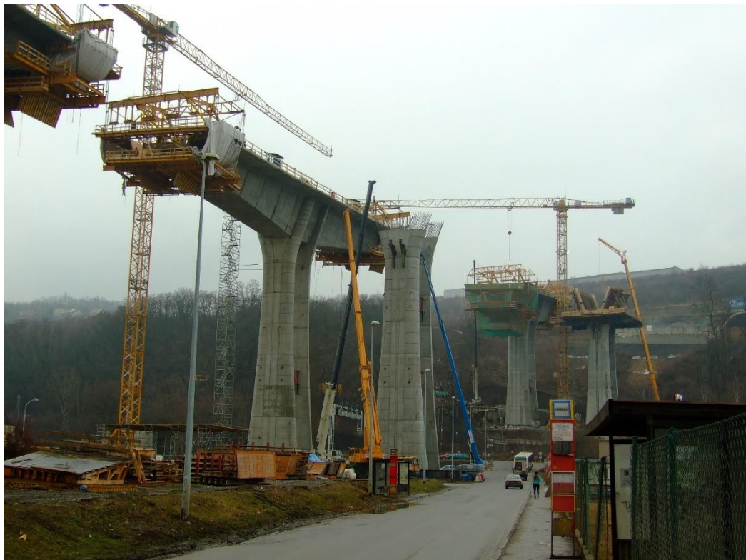
Obrázek 16 - Pohled na letmou betonáž Radotínské estakády[16]
