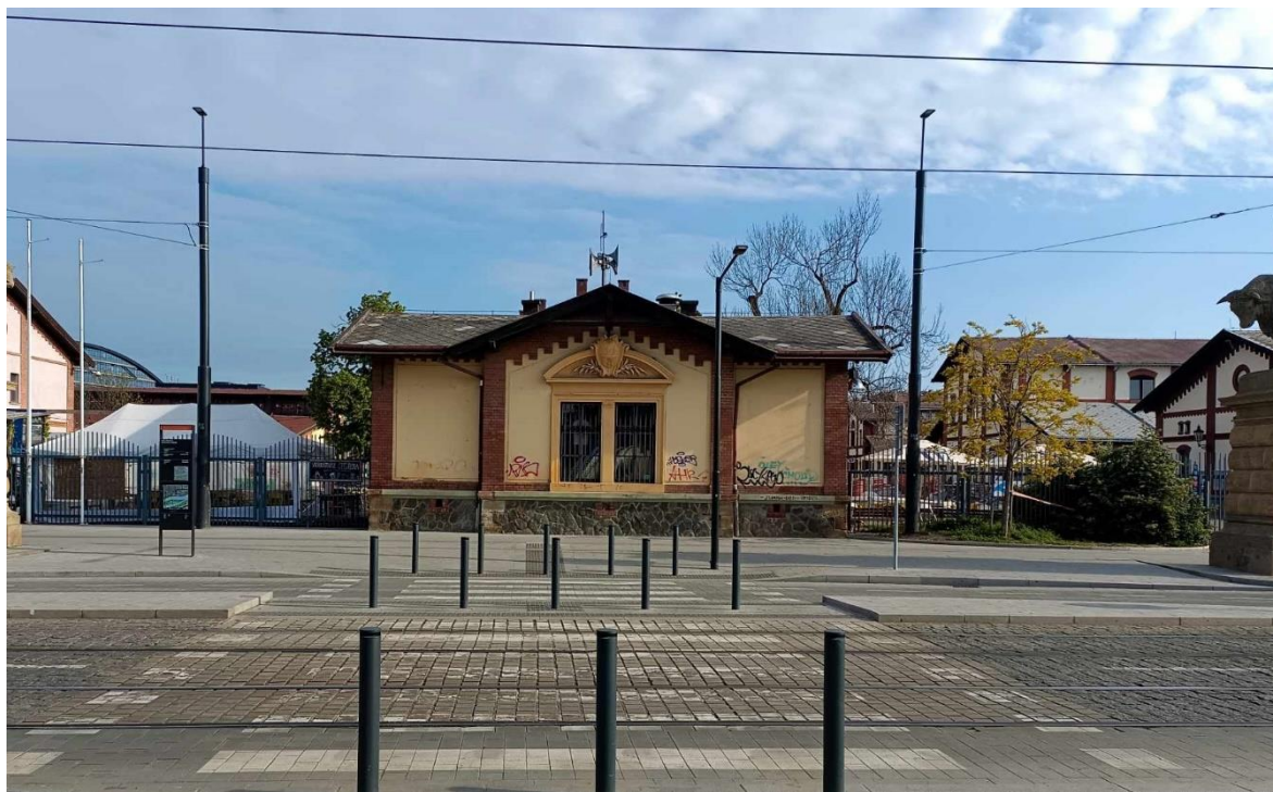
Obrázek 20 - Současný stav Haly 1, Foceno 23.4.2024. Zdroj: vlastní foto
