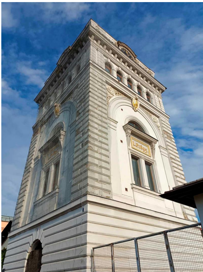
Obrázek 18 - Vodárenská věž v areálu Pražské tržnice. Zdroj: vlastní foto
