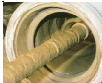
Obrázek 115. Odstředivé nanášení cementové výstelky [74]
