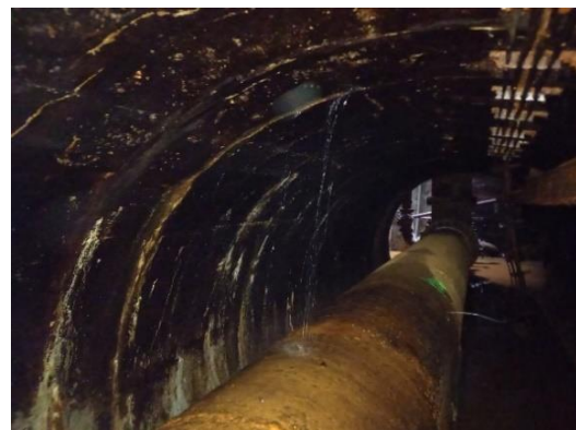
Obrázek 163: Jeden z přítoků balastní vody
