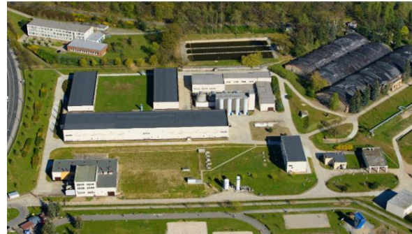
Obrázek 156: Úprava vody III. Plzeň [66]
