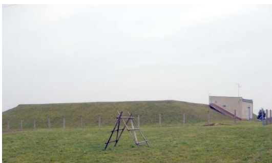
Obrázek 41: Zemní vodojem [50]
