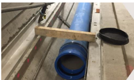
Obrázek 105: Ocelové vodovodní potrubí DN 3 [41]
