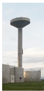
Obrázek 44: Vodojem Louny ul. Průmyslová
