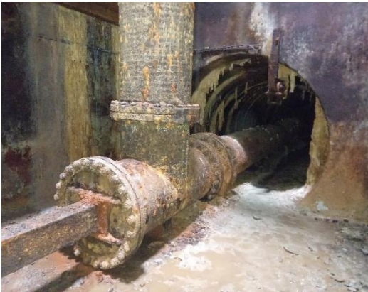
Obrázek 166: Pohled na dno šachty a začátek štoly
