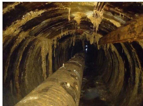
Obrázek 168: Štola podchodu – pohled po směru spádu podchodu
