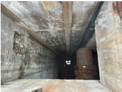
Obrázek 164: Pohled do šachty podchodu
