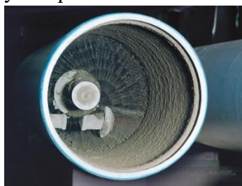
Obrázek 114: Nanášení cementové výstelky odstředěním [73]
