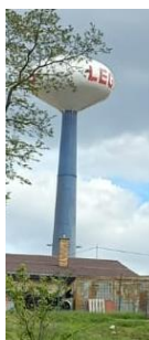
Obrázek 46: Vodojem Louny ul. Řiční
