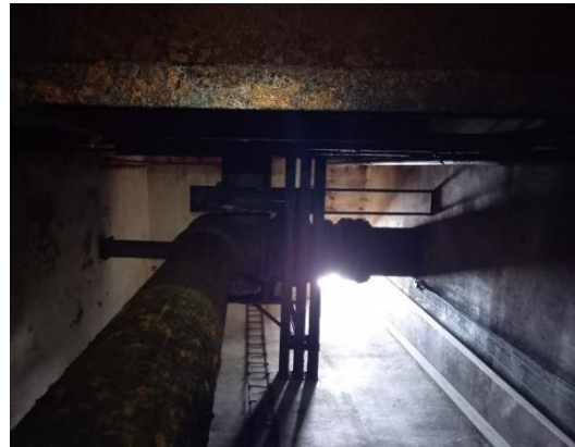
Obrázek 165: Pohled šachtou nahoru
