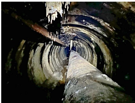
Obrázek 167: Štola podchodu – Pohled proti směru spádu podchodu
