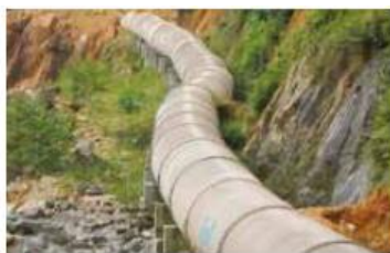
Obrázek 126: Zahýbání ve spojích [70]
