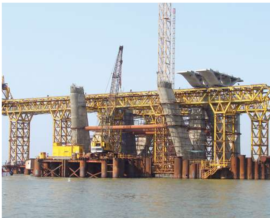
Obrázek 4-21: Stavba segmentového mostu na skruži [3]
