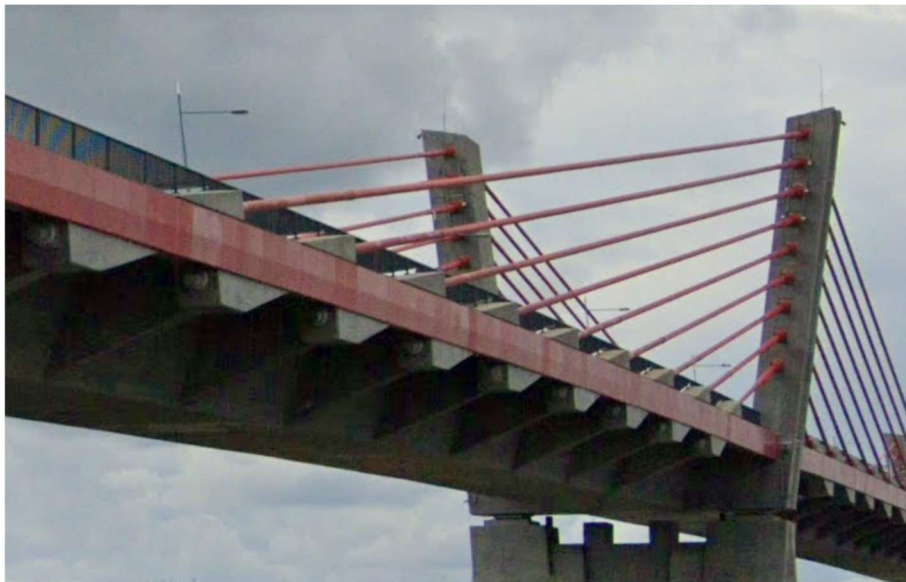
Obrázek 4-26: Detail kotvení na mostu Kwidzyn [17]
