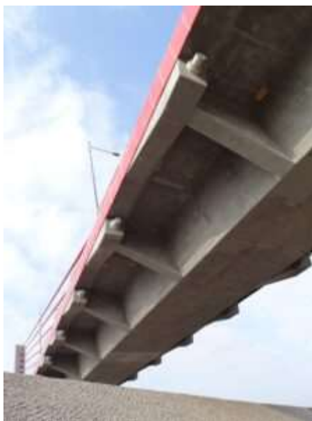
Obrázek 4-17: Kotvení kabelů a betonová diafragmata na mostu Kwidzyn [13]
