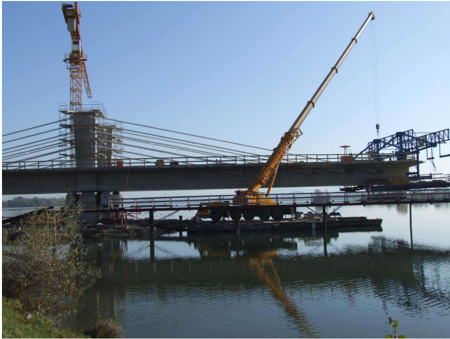
Obrázek 4-22: Letmí betonáž mostu Puch v Ptuji [19]
