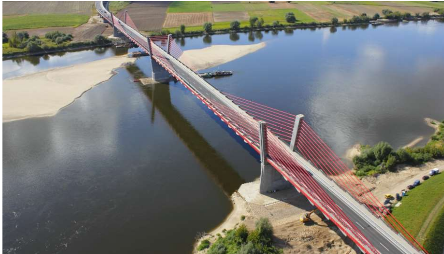
Obrázek 4-27: Pohled na most Kwidzyn [9]
