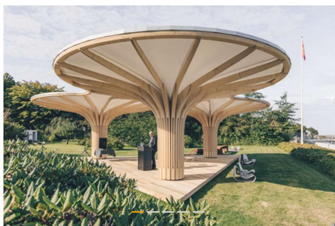
Obr. 28: Využití rotační konzolové konstrukce - dřevěný pavilon „Into the woods“ Švýcarské velvyslanectví, Kodaň, Dánsko [21]
