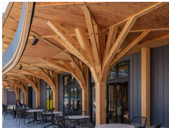
Obr. 8: Příklad tuhé roznášecí hlavice z několika dílčích prvků [14]
