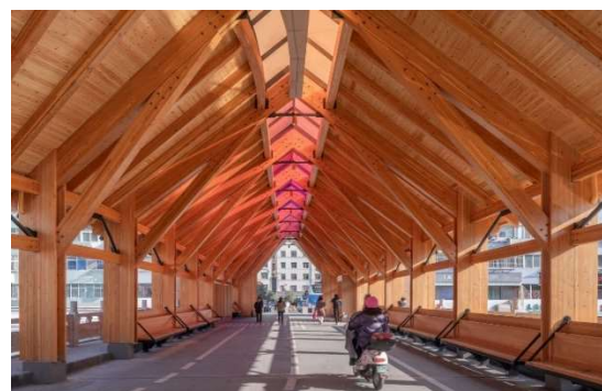
Obr. 32: Zastřešení lávky pro pěší, Longnan, Čína [14]
