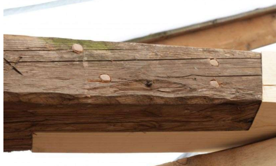
Obr. 12: Příklady použití dřevěných kolíků [16]
