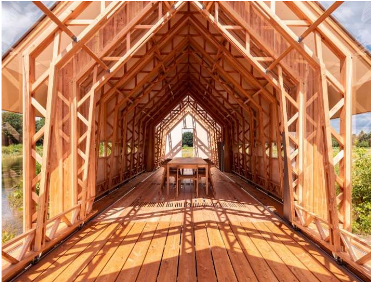
Obr. 35: Příhradová rámová konstrukce – Chata v Nizozemí [14]
