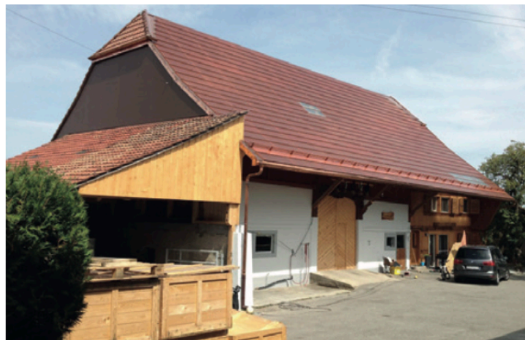
Obrázek 13: Fotovoltaické tašky terakotového vzhledu na venkovské farmě, vesnice Ecuwillens (12)
