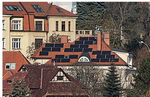
Obrázek 12: negativní příklady instalace FVS na valbové střeše s keramickou střešní krytinou, narušuje celkovou kompozici objektu, jeho architektonické působení včetně jeho uplatnění v širším kontextu, viditelnost FVS v blízkých i dálkových pohledech, kontrast mezi střešní krytinou a FVS má negativní dopad na střešní krajinu daného území (12)
