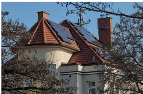
Obrázek 12: negativní příklady instalace FVS na valbové střeše s keramickou střešní krytinou, narušuje celkovou kompozici objektu, jeho architektonické působení včetně jeho uplatnění v širším kontextu, viditelnost FVS v blízkých i dálkových pohledech, kontrast mezi střešní krytinou a FVS má negativní dopad na střešní krajinu daného území (12)
