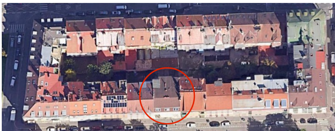
Obrázek 19: pohled shora na blokovou zástavbu činžovních domů (15)
