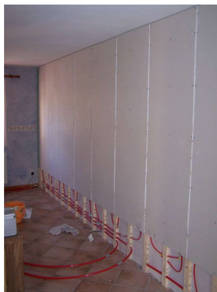
Obrázek 23: Příklad instalace suchého stěnového vytápění [10]
