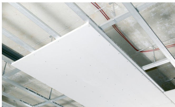
Obr. 6-14 Namontovaná stropní deska
