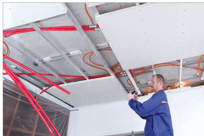
Obr. 6-24 Propojení připojovacího potrubí
