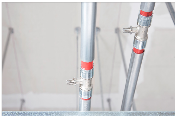
Obr. 6-23 Připravené T-kusy pro napojení stropních desek
