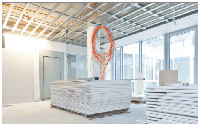
Obr. 6-10 Paleta se stropními deskami
