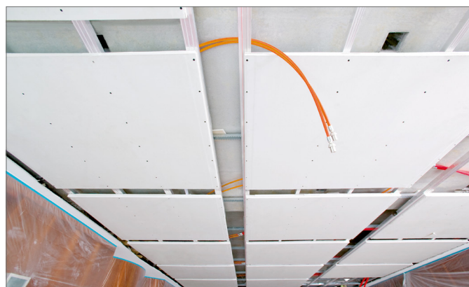
Obr. 6-7 REHAU systém stropního vytápění / chlazení - suchý způsob
