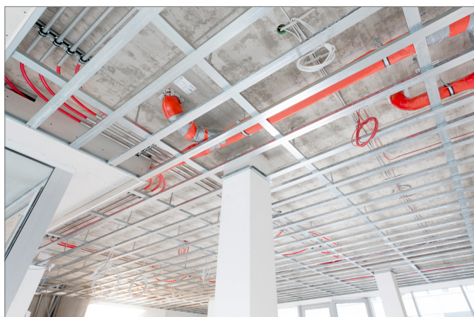
Obr. 6-22 Připravená konstrukce podhledu
