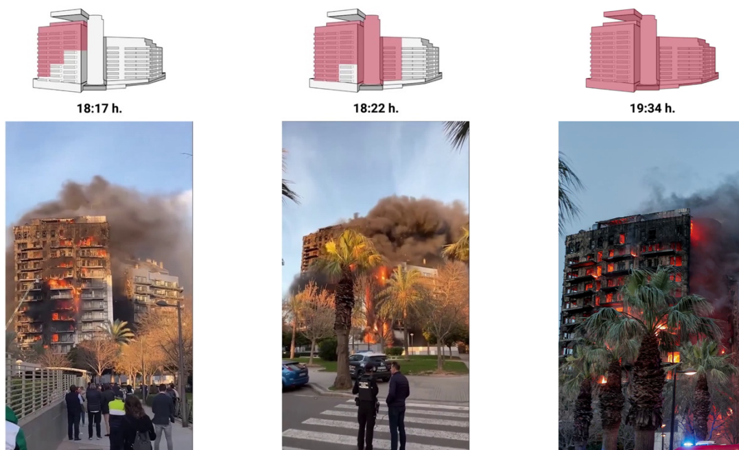
Obrázek 6-3 Průběh požáru bytového domu ve Valencii – druhá fáze [43]
