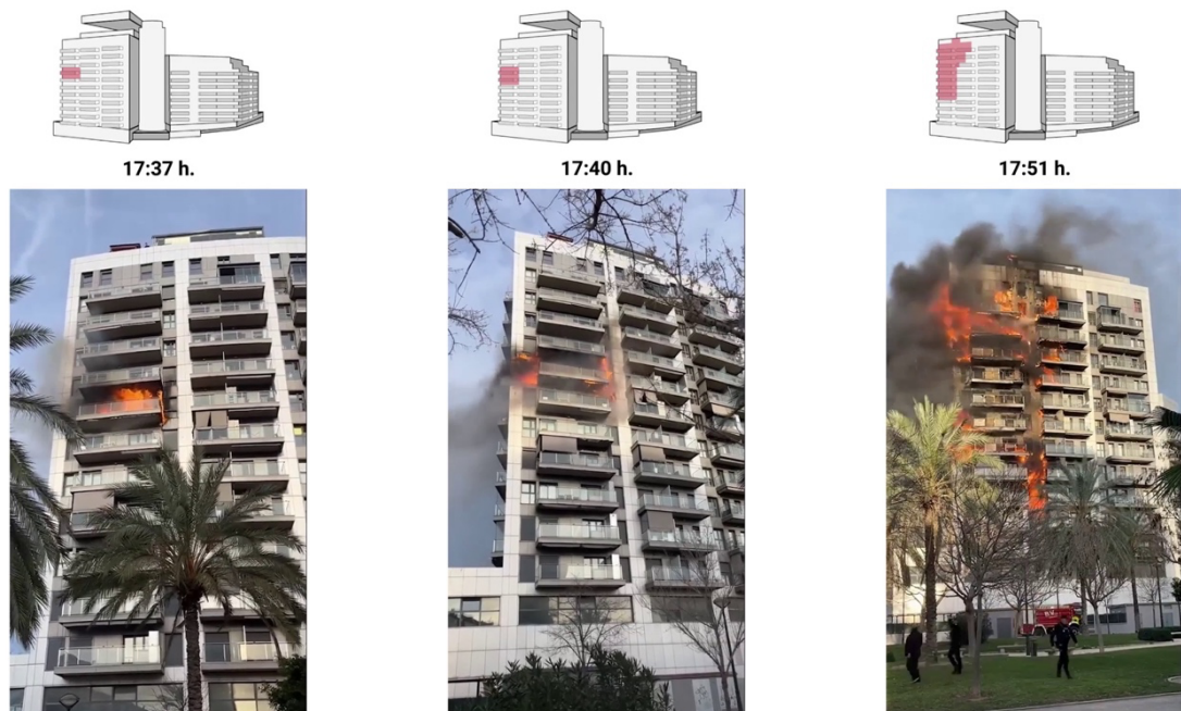
Obrázek 6-2 Průběh požáru bytového domu ve Valencii – první fáze [43]
