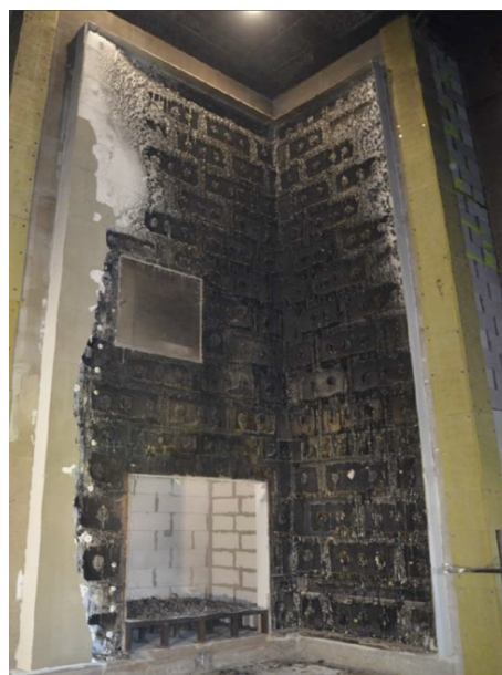
d) Po odstranění fasádní omítky
