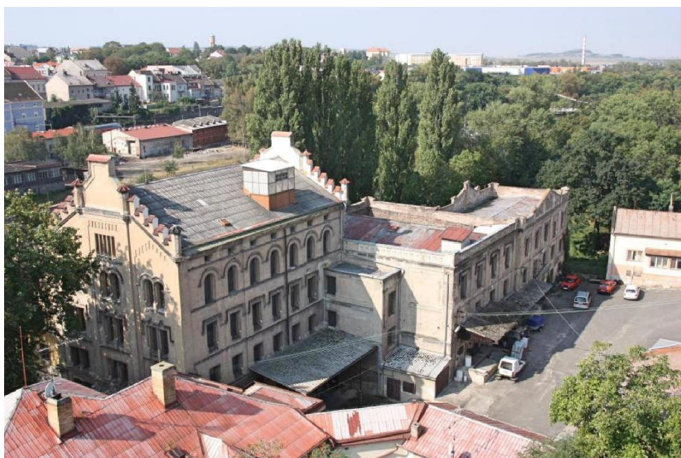
Obr. 2: Původní stav Radimského mlýna
