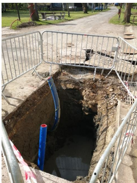
[Obr. 29] Startovací/cílová jáma, zde dochází ke spoji potrubí [zdroj vlastní]
