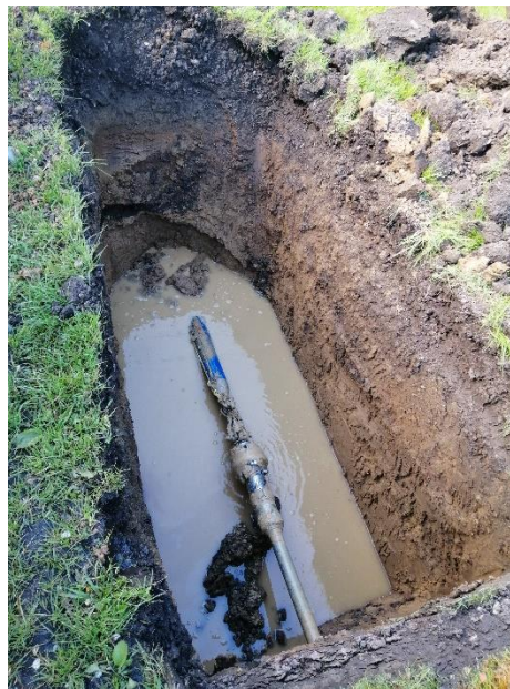
[Obr. 26] Zatahování potrubí za rozšiřovací hlavou [zdroj vlastní]
