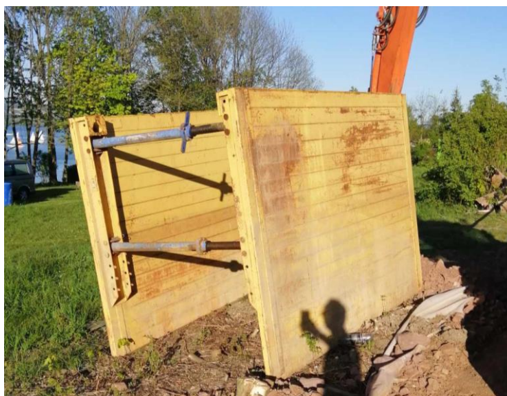
[Obr. 24] Pažící box [zdroj vlastní]
