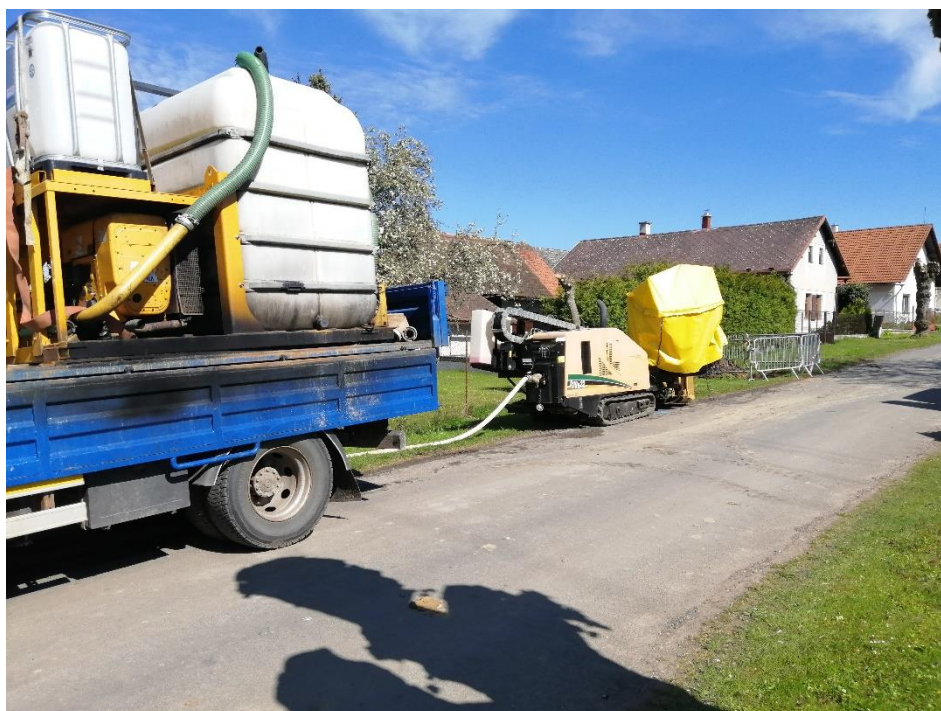
[Obr. 31] Vrtný stroj v pravé části obrázku a vlevo doprovodné nákladní auto s vodou pro výplach a čerpadlem [zdroj vlastní]
