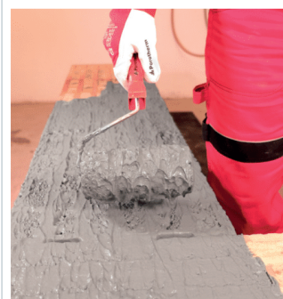
Nanášení celoplošné malty moltroprenovým válečkem Porotherm Easy na celou plochu ložné spáry cihel plněných minerální vatou
