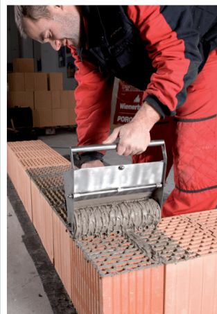
Nanášení válcem na žebra cihel
