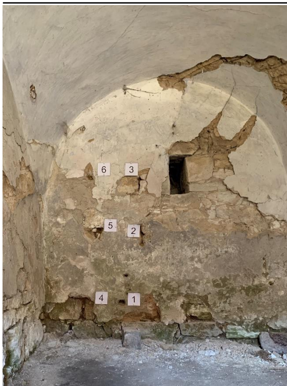
Obrázek 70: Pozice odebraných vzorků – chlívek 1.NP
