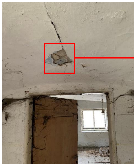
Obrázek 68: Umístění sádrového terče 1 na pruskou klenbu nad chodbou
