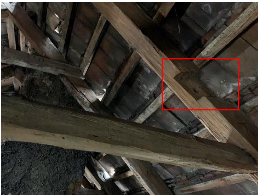
Obrázek 54: Opětovně použitá krokev s oslabeným průřezem
