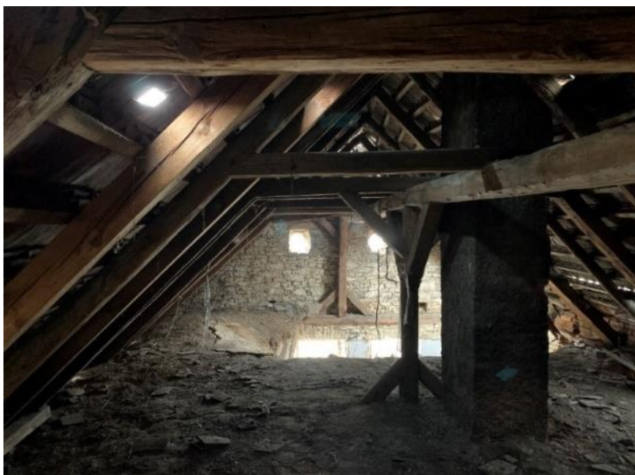
Obrázek 16: Krov hlavní část - pohled jižní
