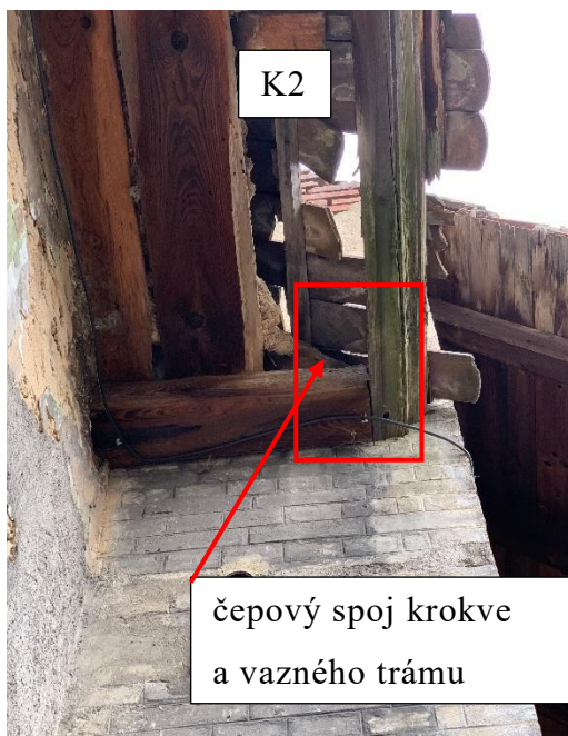
Obrázek 18: Uložení krajní krokve
