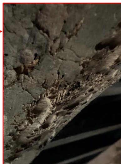
Obrázek 47: Krokev – výletové otvory od tesaříka
