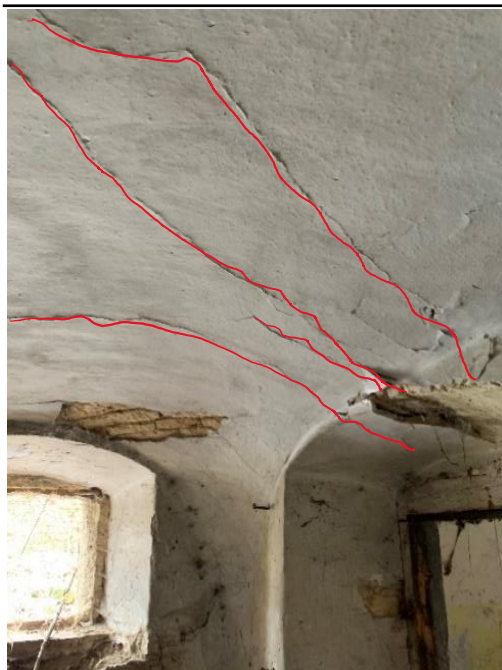
Obrázek 39: Skupina trhlin u vchodu do chlívků 1.NP
