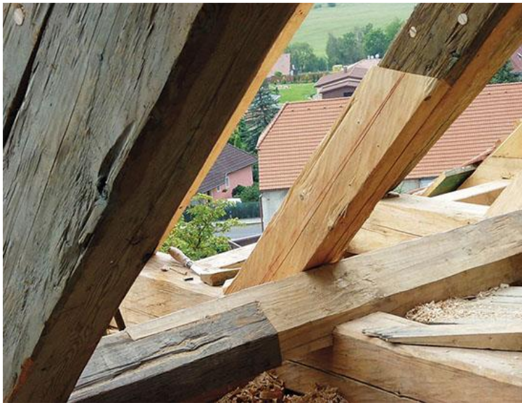
Obrázek 125: Ilustrační snímek protézování krokví pomocí dřevěných kolíků [16]
