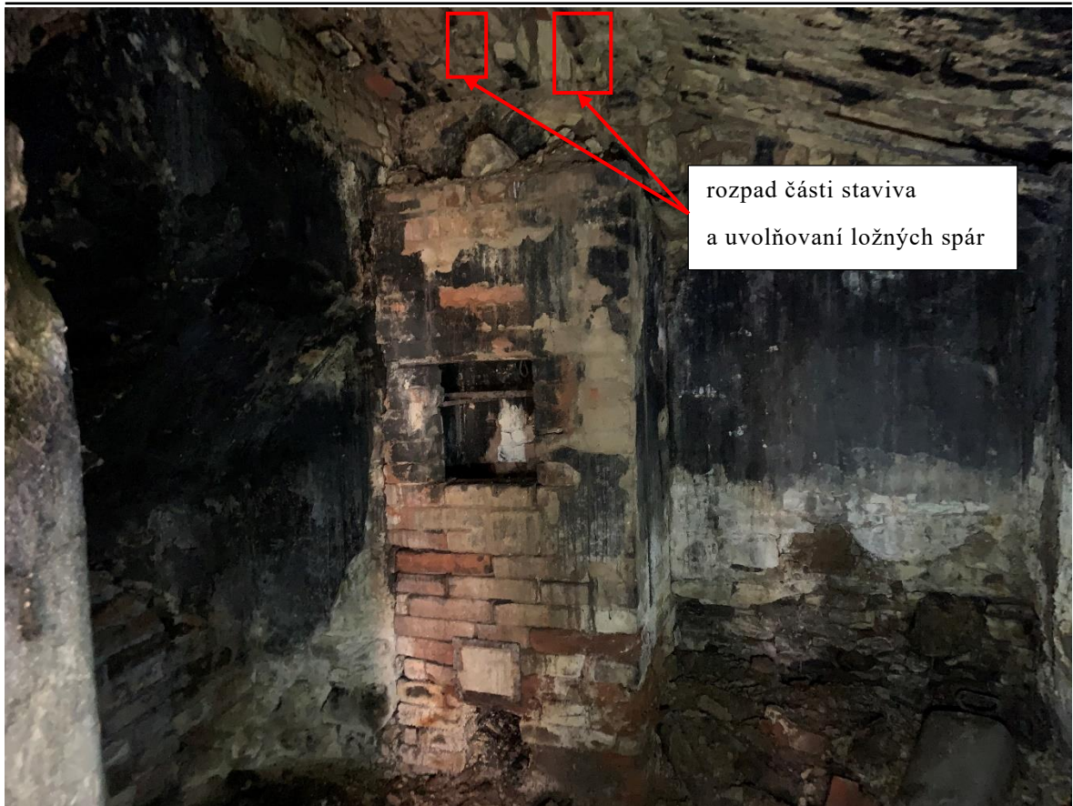
Obrázek 43: Česká klenba s rozvolněným kusovým stavivem
