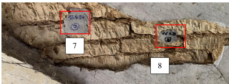
Obrázek 67: Pruská klenba nad chlívkem – sádrové terče: 7,8
