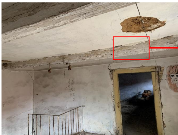
Obrázek 44: Dřevěný trámový strop 2.NP
