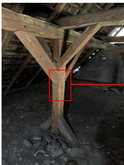
Obrázek 48: Střední sloupek
