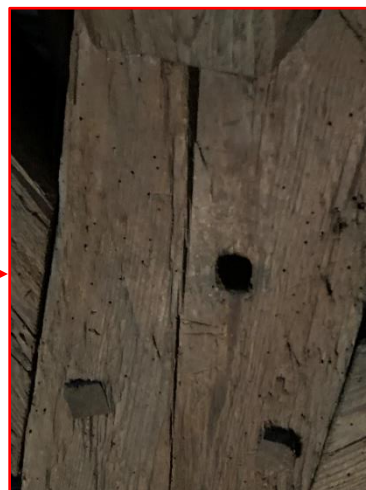
Obrázek 49: Vnitřní sloupek – výletové otvory od červotoče
