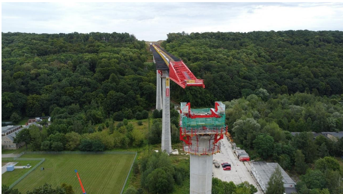
Obr. 3 Fotografie z realizace – stav před nájездem konstrukce na pilíř 50. [5]
