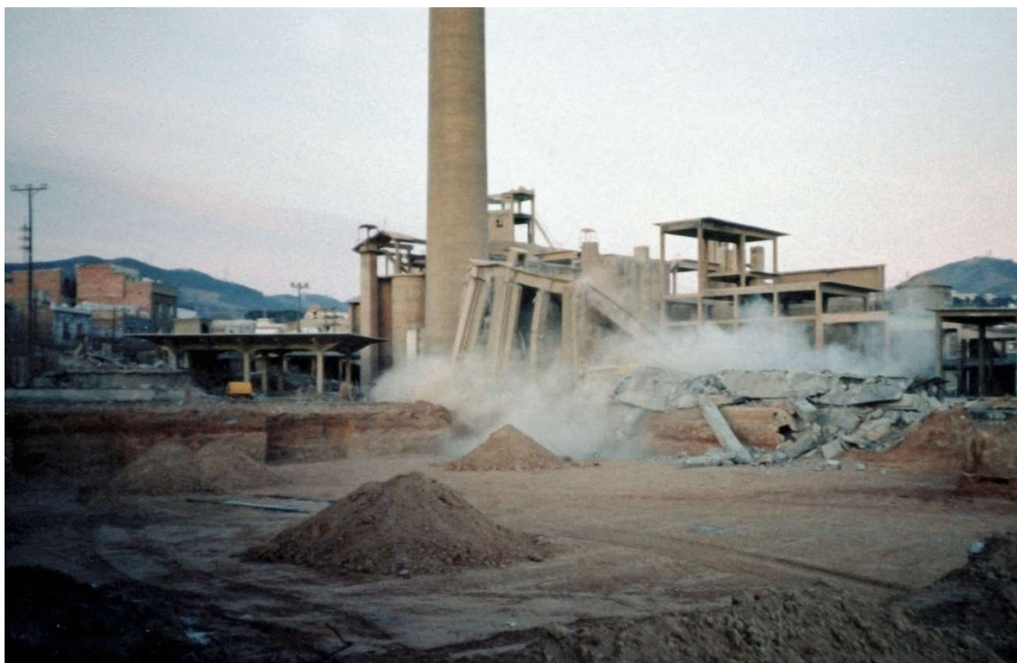
Obrázek 3.22 - Fotky z demolice [4]
