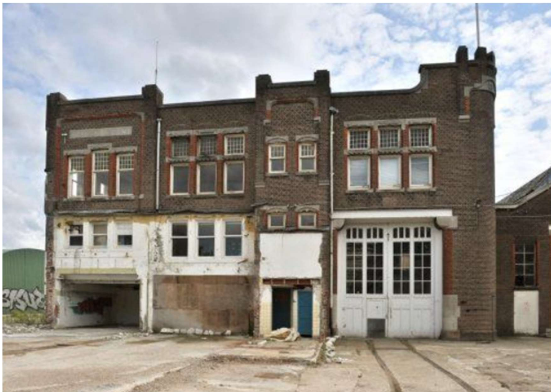
Obrázek 35 - Stav před rekonstrukcí [8]
