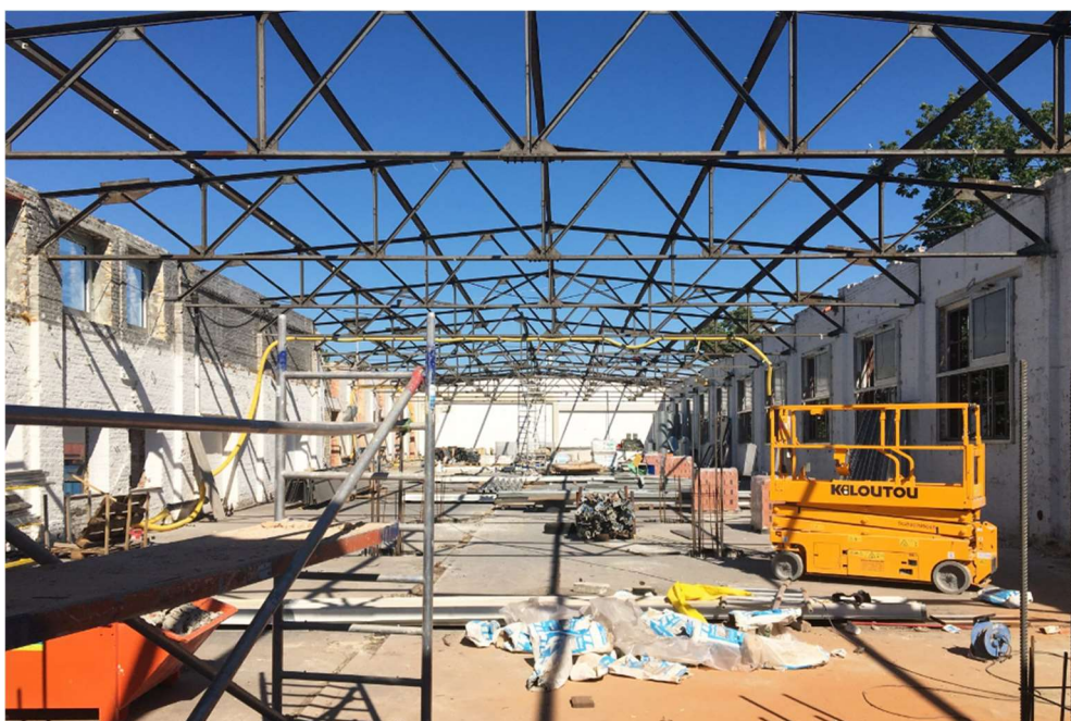
Obrázek 43 - Práce při rozebrání střechy [16]
