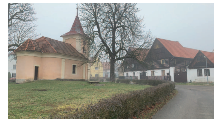
Původní historická zástavba
