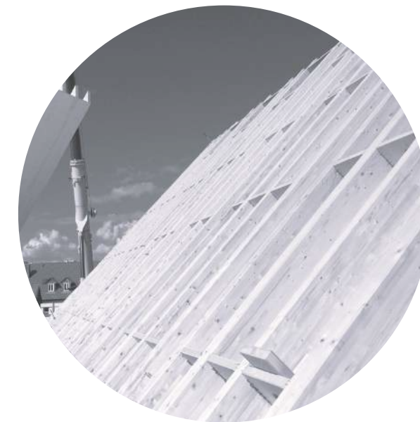
žebrový strop a střeška z SWP nosných plochů zaklopených CLT deskou - u stropu v pohledové kvalitě
