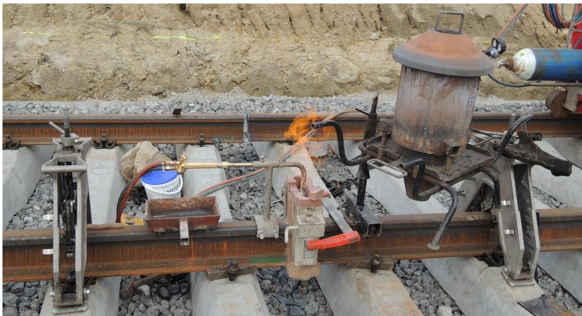
Obr. 52 - Předeheřv konců kolejnic, viditelné směrové vyklínování a svařovací sestava [Zdroj: Ing. Ondřej Bret]
