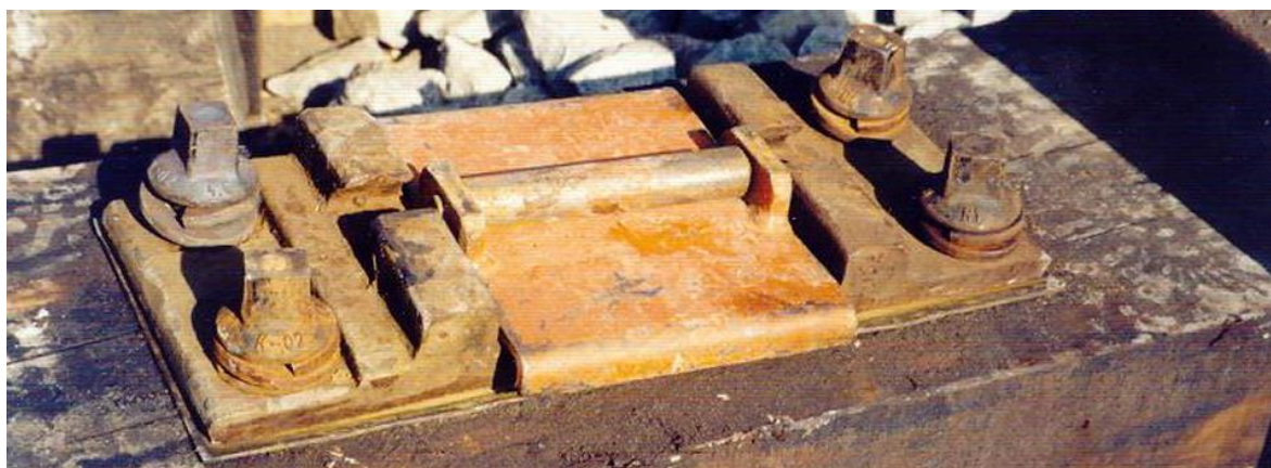
Obr. 34 - Válečková kluzná podložka pod patu kolejnice [36]
