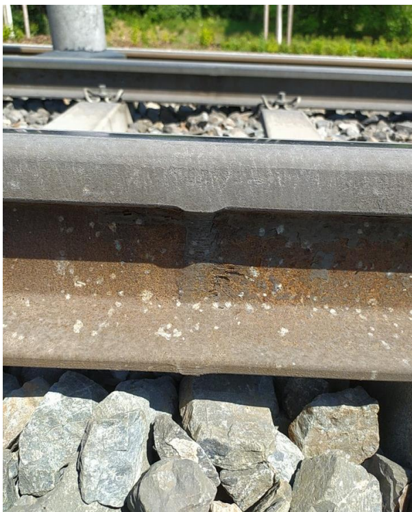
Obr. 77 - Detail svaru [Zdroj: Autor]
