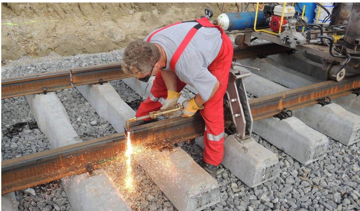
Obr. 47 - Úprava svařovací spáry řezáním plamenem [Zdroj: Ing. Ondřej Bret]
