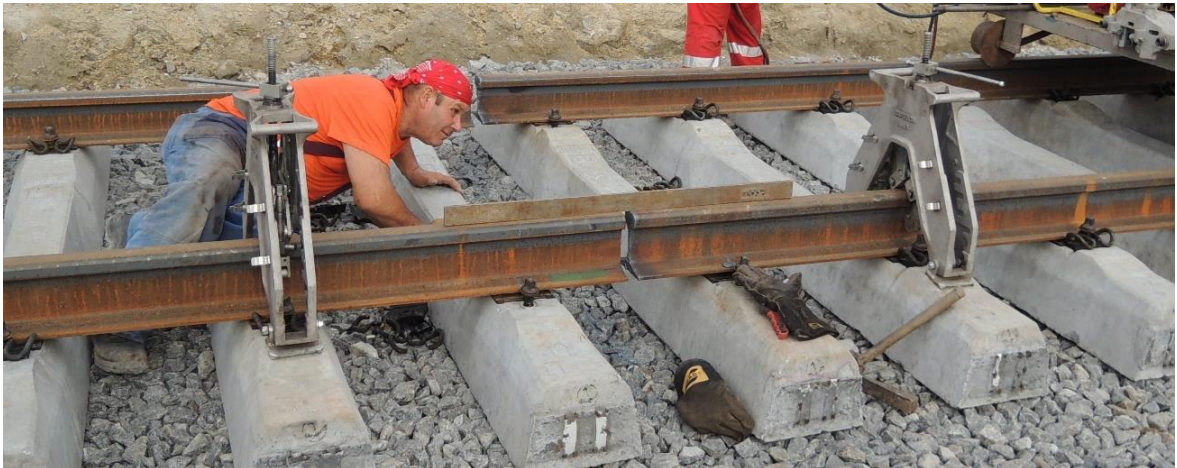
Obr. 48 - Kontrola správné výškové polohy konců kolejnic [Zdroj: Ing. Ondřej Bret]
