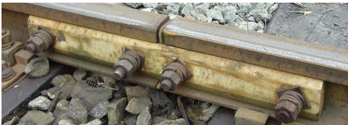
Obr. 1 - Izolovaný kolejnicový styk [4]
