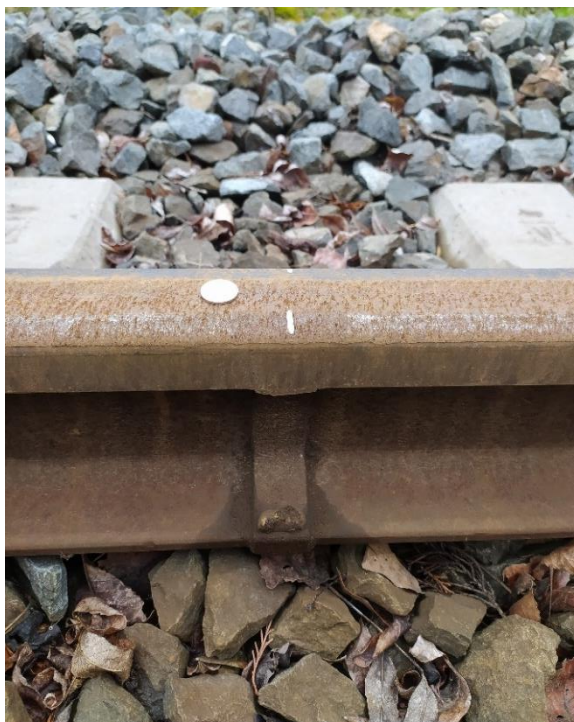
Obr. 79 - Detail svaru [Zdroj: Autor]
