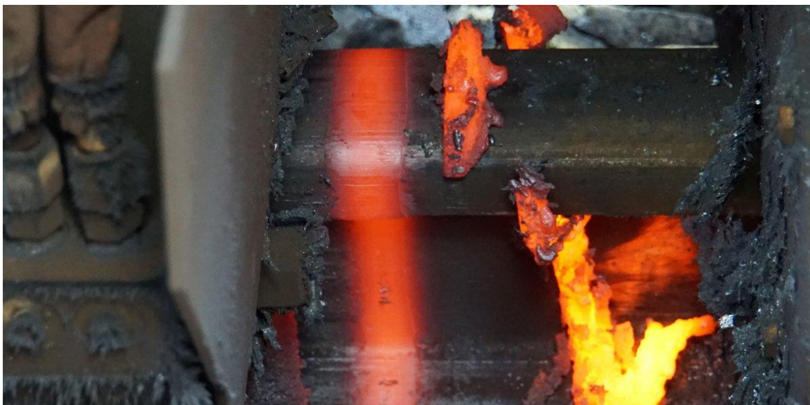
Obr. 61 - Svar po seříznutí výronku [58]
