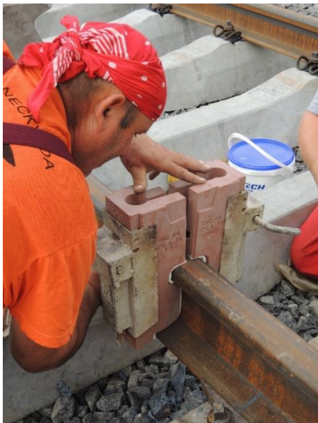
Obr. 50 - Montáž suché prefabrikované formy [Zdroj: Ing. Ondřej Bret]
