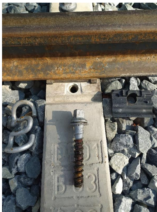
Obr. 26 – Jednotlivé součásti upevnění [Zdroj: Autor]
