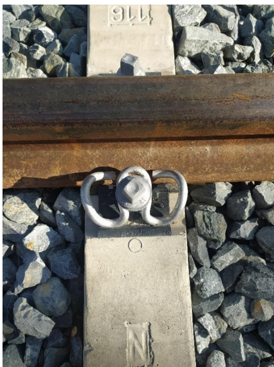
Obr. 27 – Bezpodkladnicové upevnění kolejnice 49 E1 na betonových pražcích B03-DP01 s pružnou svěrkou Vossloh Skl 14 [Zdroj: Autor]
