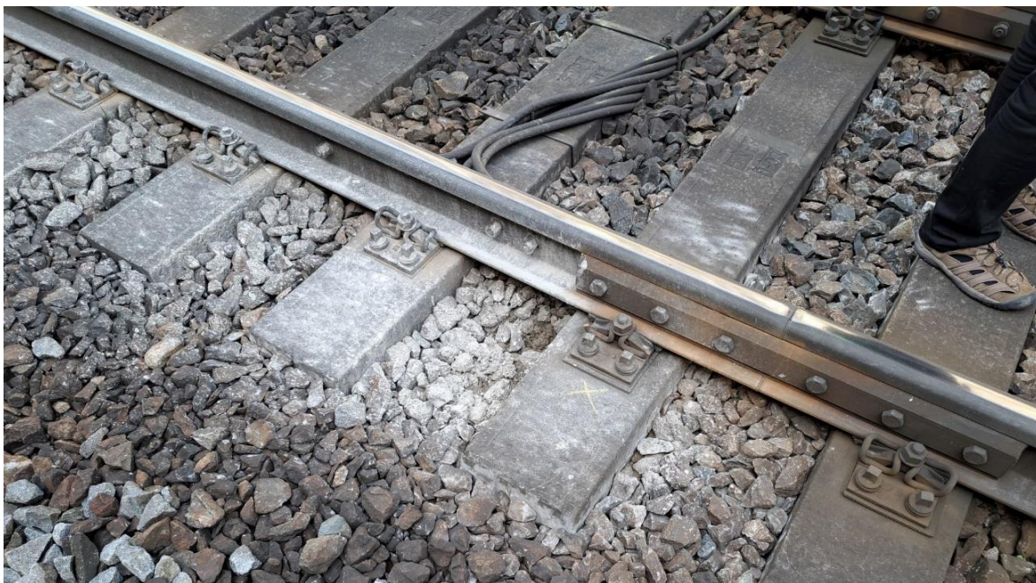
Obr. 3 - Blátivý styk [Zdroj: Ing. Petr Břešťovský, Ph.D.]
