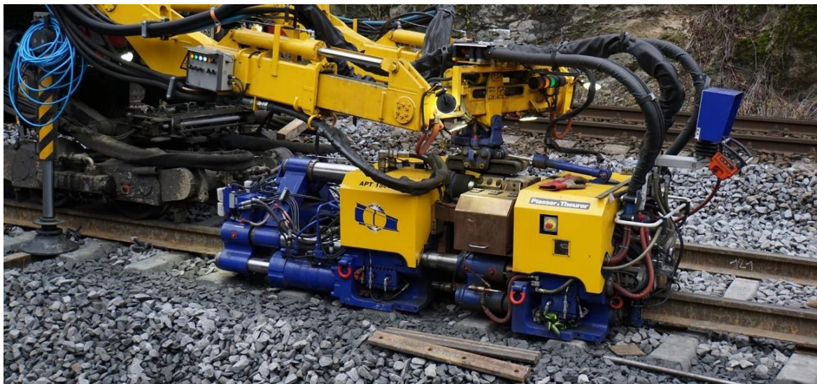
Obr. 62 - Přizvednutí kolejnic svařovací hlavou [58]
