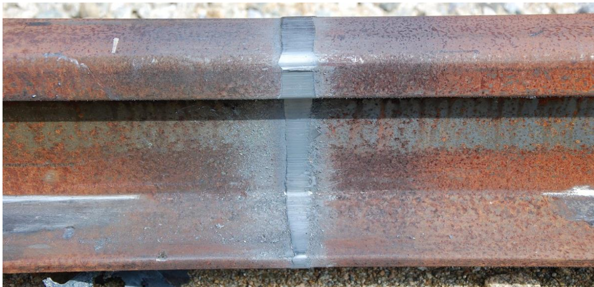
Obr. 57 – Svar provedený stykově s odtavením [58]
