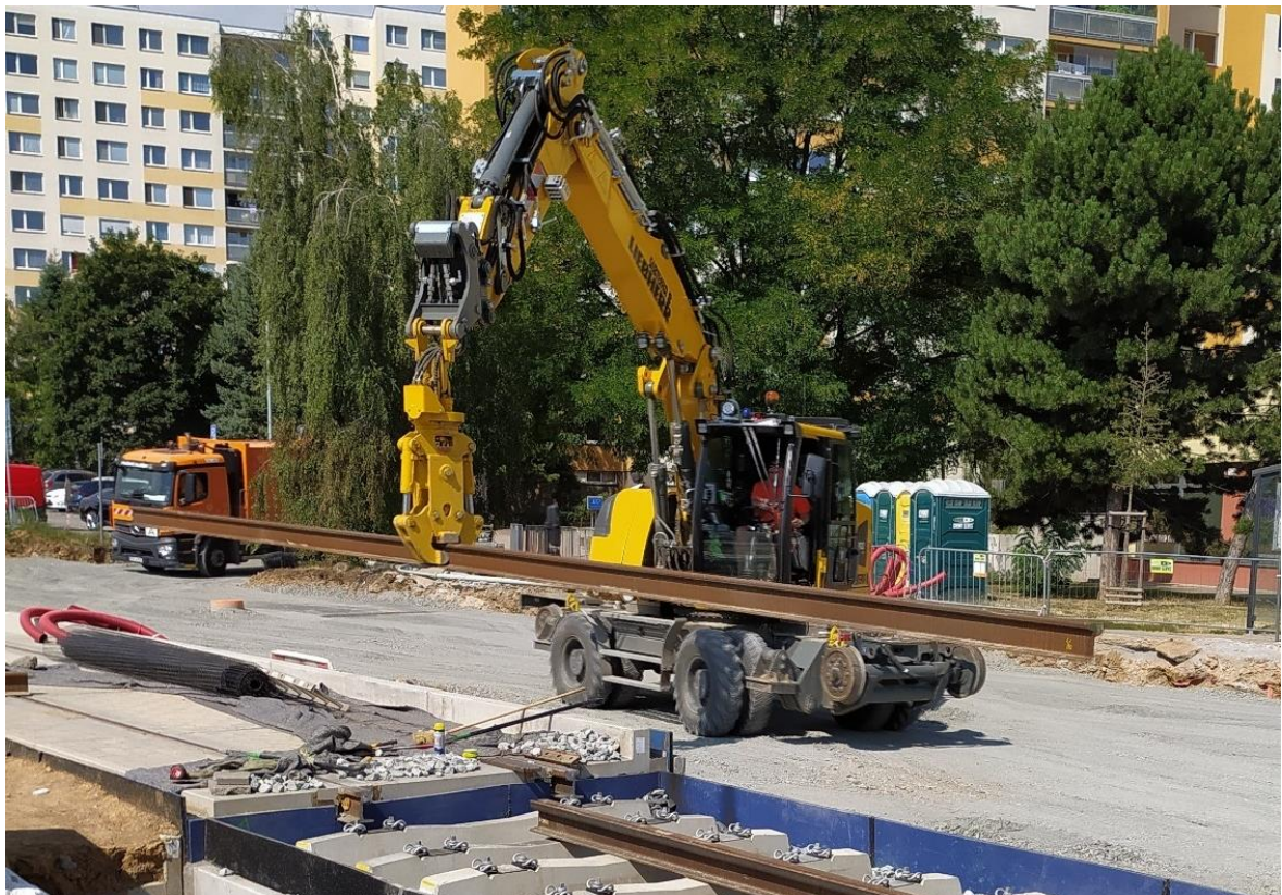
Obr. 41 - Přesun kolejnice pomocí dvoucestného bagru s kolejnicovými kleštěmi [Zdroj: Autor]
