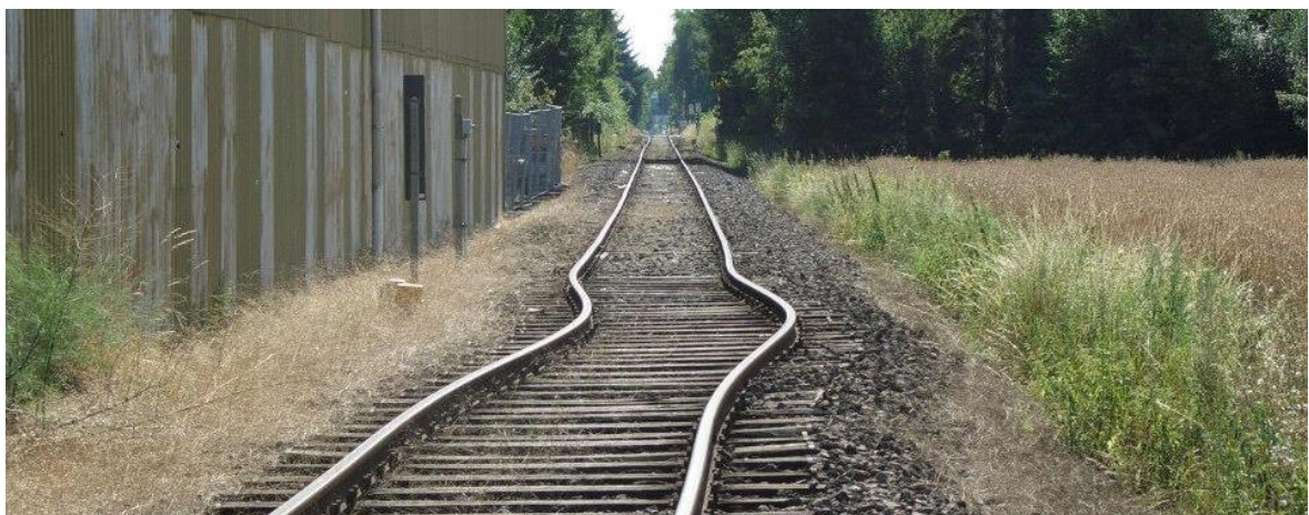
Obr. 20 - Vybočení kolejového roštu ve vodorovné rovině na bývalém vlakovém nádraží Gütersloh Ost [25]
