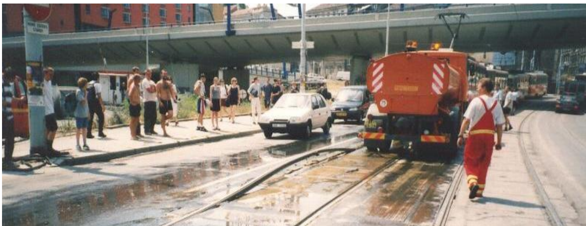
Obr. 17 - Teplem vzduť kolejnice B1 ve velkoplošném panelu BKV na Plzeňské ulici, u zastávky Anděl dne 21. června 2000 [23]
