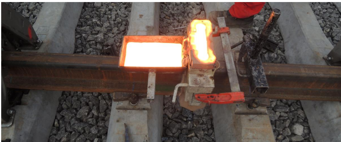
Obr. 53 - Uvolněný tekutý kov ve formě a nádobě na strusku [Zdroj: Ing. Ondřej Bret]
