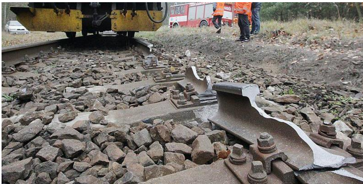
Obr. 13 – Vylomení částí hlavy kolejnice Rosice nad Labem 17. listopadu 2011 [18]
