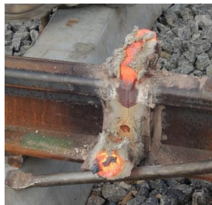
Obr. 54 - Odklon nálitků výfukových otvorů [Zdroj: Ing. Ondřej Bret]
