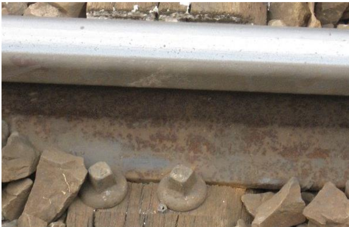
Obr. 5 - Přímé upevnění s vrtulemi na dřevěném pražci (Francie) [4]
