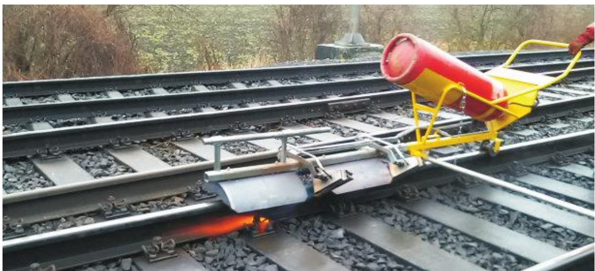
Obr. 39 - Zařízení pro ohřev kolejnic [39]
