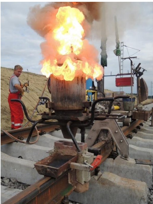
Obr. 46 - Hoření termitové směsi [Zdroj: Ing. Ondřej Bret]
