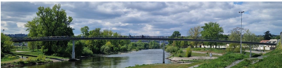
Obrázek 2.1: Pohled na Trojskou lávku z pravého břehu po proudu řeky
